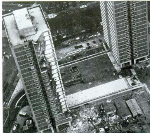
Tavv. 2.2 e 2.3 - Crollo di Ronan Point, Londra, 1968. Lo schemino illustra la dinamica del crollo. Per effetto di uno scoppio, è venuto a mancare il pannello di chiusura portante al 18° piano. Mancando il supporto, sono crollati i piani sovrastanti che caricando il 17° piano hanno provocato il collasso a catena (F. Laner, Il nuovo cantiere , n. 1, gennaio 1985)
