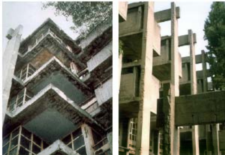
Foto 1.1 - Corrosione da carbonatazione (Milano Istituto Marchionni), dopo 50 anni di servizio.
