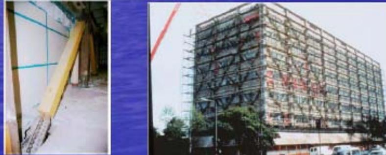
*Inserimento di controventi dissipativi in un edificio esistente*
