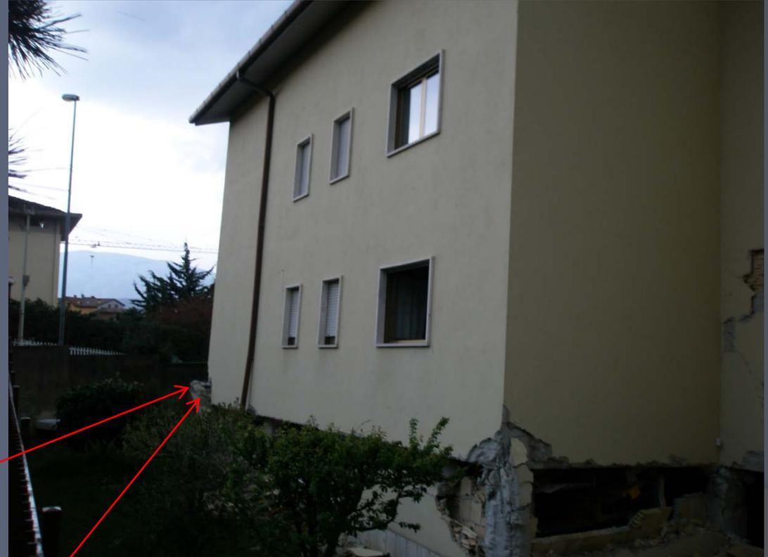
Piano quasi crollato. I pilastri erano meno resistenti delle travi
