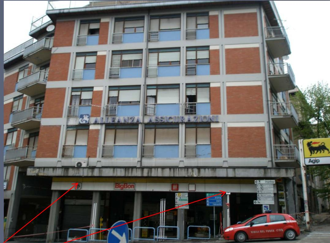
I pilastri erano più resistenti delle travi, non si è formato un meccanismo di piano
