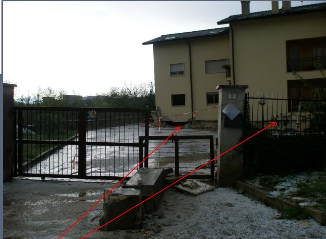
Piano crollato. I pilastri erano meno resistenti delle travi
