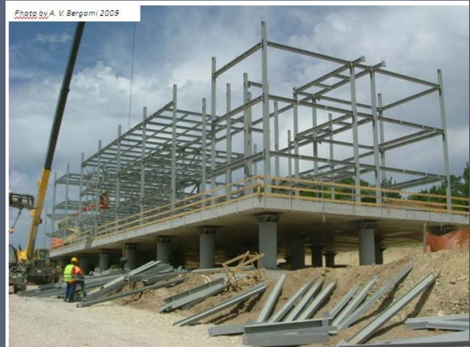
*Realizzazione di strutture isolate alla base: progetto C.A.S.E. edificio in zona Bazzano L'Aquila. Struttura metallica su piastra in c.a. isolata alla base con isolatori "friction pendulum"*
