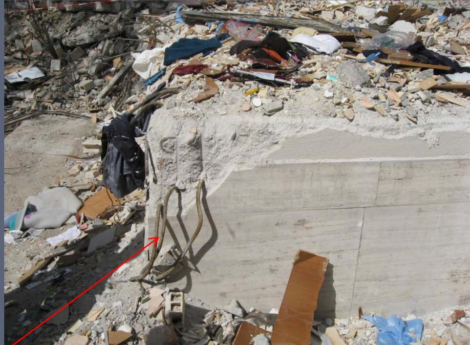
Ancoraggio inadeguato dello spiccato pilastri e mancanza ferri orizzontali in fondazione
