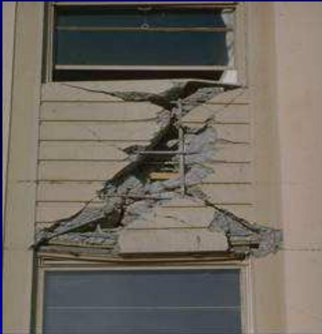
Rottura per taglio del trasverso
