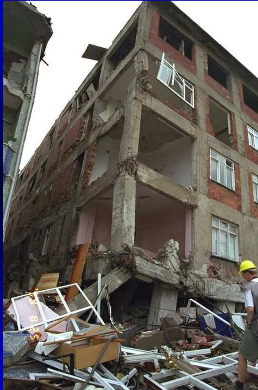
***Telai ad Alta duttilità: gerarchia delle resistenze
