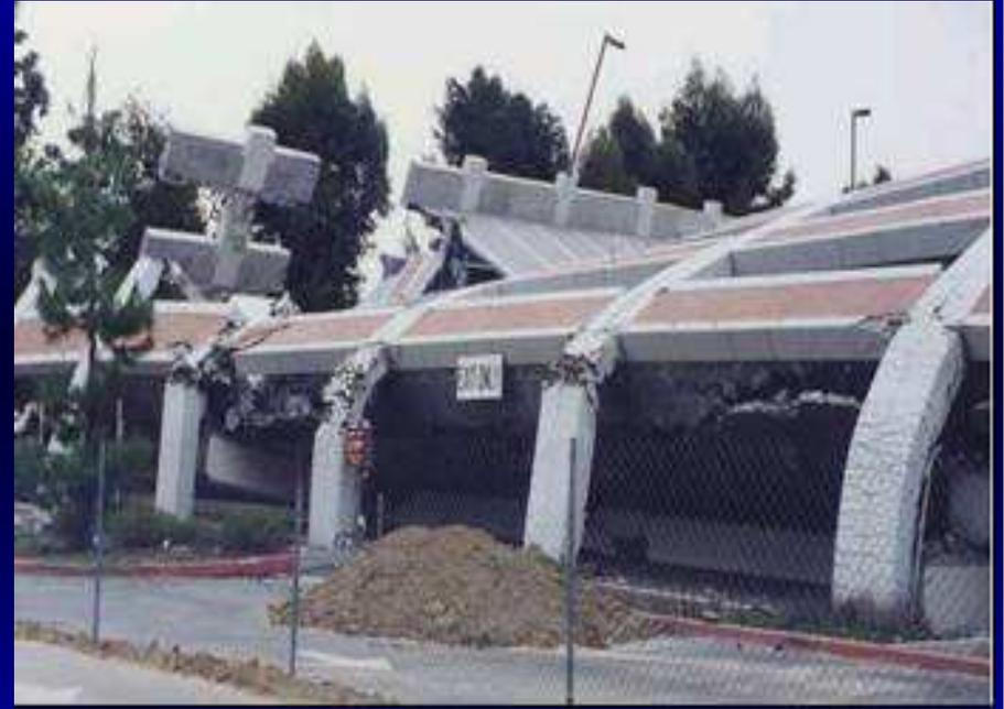
Tipico collasso dovuto a ridotta iperstaticità (telai solo di perimetro).
