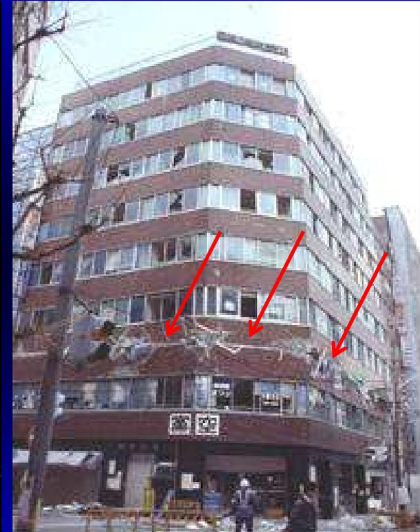
Tipici meccanismi da piano soffice di telai in c.a.
