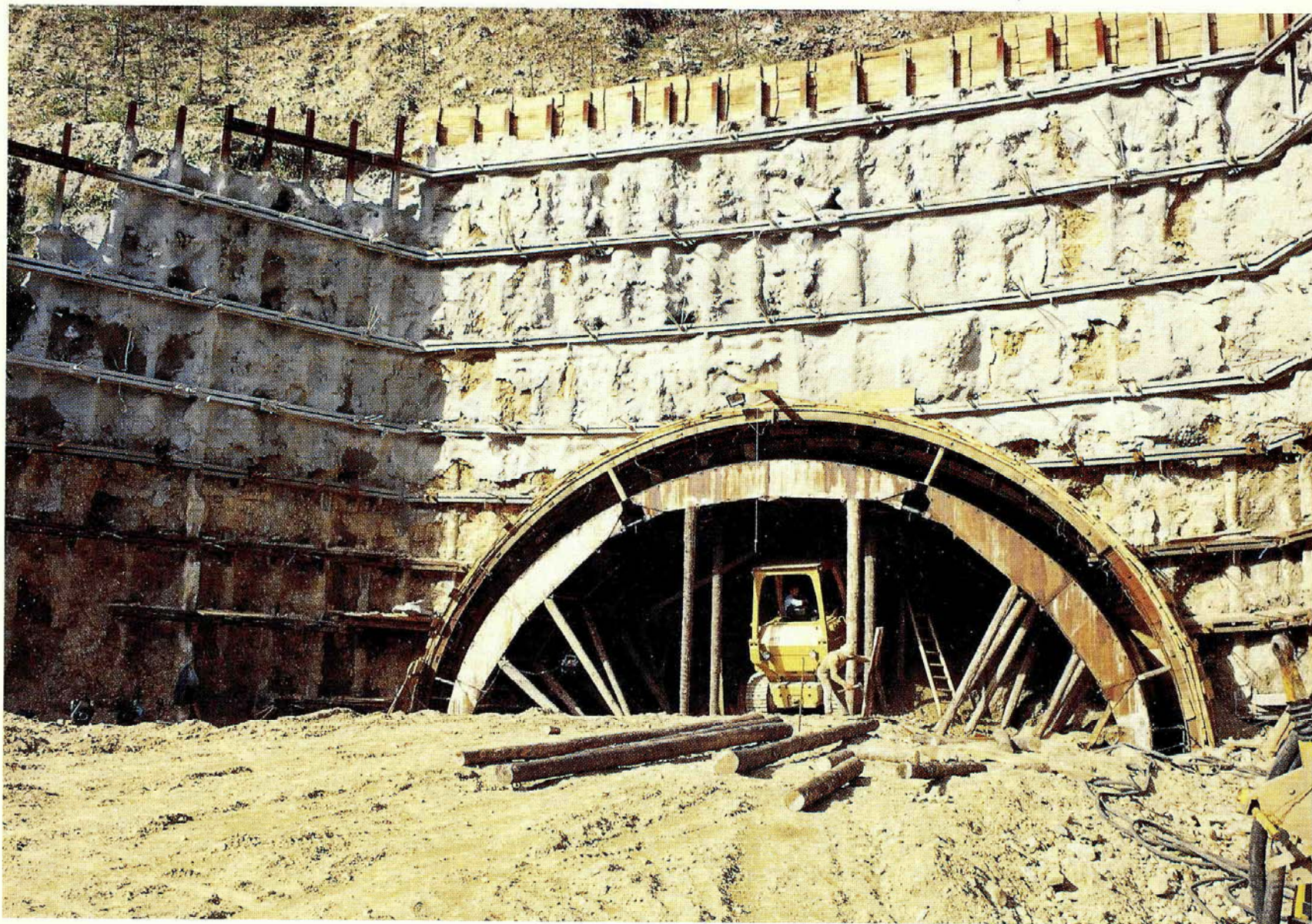
4.13 Galleria Torbido, lato Jonio - Opere di sostegno realizzate con micropali, profilati e tiranti
