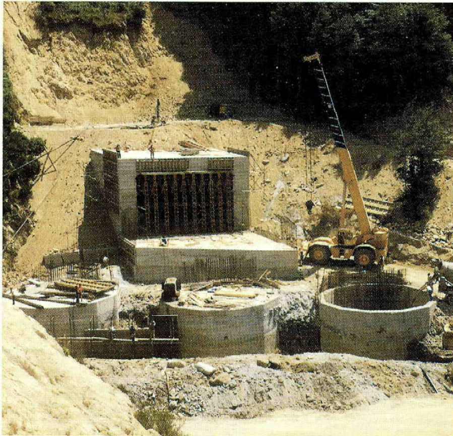
4.4 Consolidamento in fase di realizzazione
