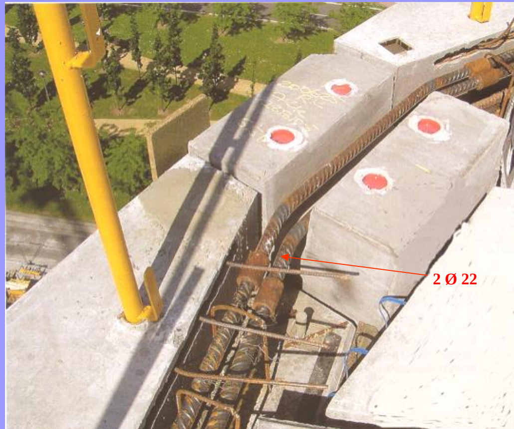
Particolare di incatenamento
