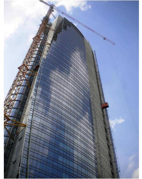
*Vista della Torre A con le facciate lato Parco in fase di completamento. Sul lato di sinistra è visibile il dettaglio della struttura portante della facciata creato al fine di realizzare la sagoma laterale della Torre.*
