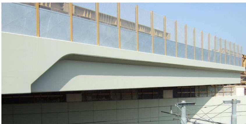
Figura 5 – Prospetto laterale con la sagoma stilizzata del treno ad Alta Velocità
