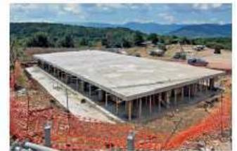
FASE 12\_ Basamento isolato prima della rimozione dei puntelli di sostegno della piastra superiore
