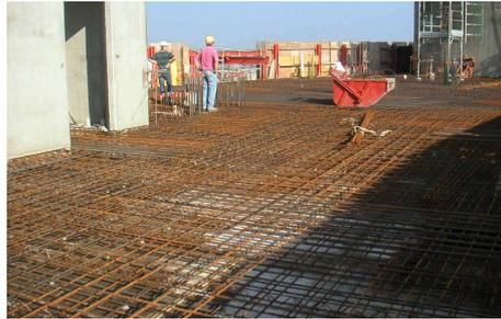
Fig. 25: Particolare di armatura di un solaio a piastra della Torre A.
