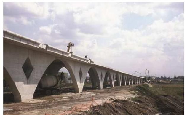
Figure 17 e 18: Particolare della veletta prefabbricata e posa in opera
