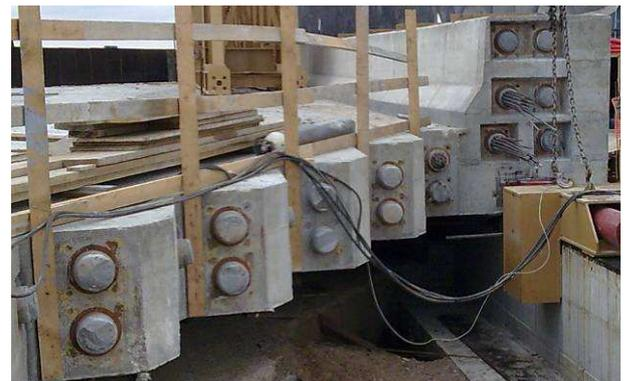
Figura 7 – Le testate dei cavi nella zona dell'angolo ottuso
