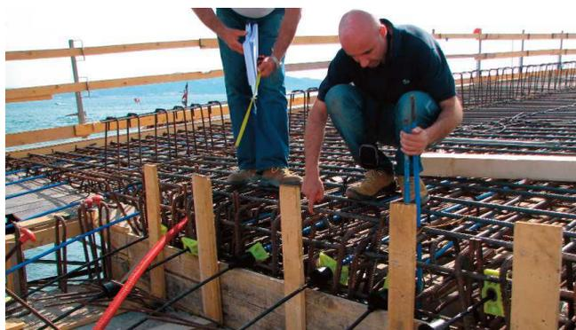
*Dettaglio in corrispondenza della chiave del ponte degli ancoraggi a tendere dei cavi di post-tensione e della cerniera di collegamento tra le due metà del ponte*
