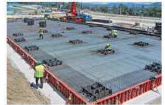
FASE 4\_ Posa degli ancoraggi di base delle colonne metalliche dopo la posa dell'armatura inferiore e la realizzazione delle sponde perimetrali
