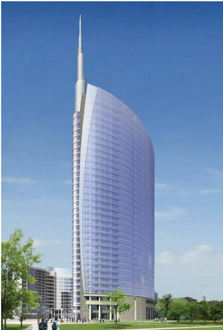
*Rendering architettonico della Torre A vista dai futuri giardini di Porta Nuova. E' visibile il profilo bombato realizzato con le strutture di facciata voluto dall'architetto Cesar Pelli. Nella parte retrostante è visibile la Torre C.*
