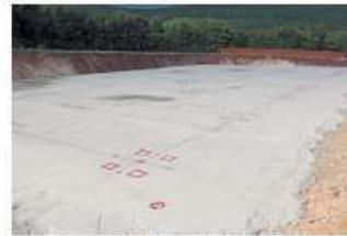
FASE 3\_ Tracciamento per la posa degli ancoraggi di base per le colonne metalliche
