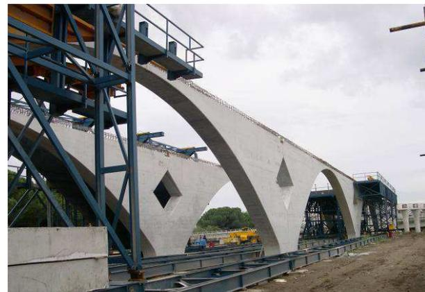
Figura 14: Viste d'assieme delle casseforme
