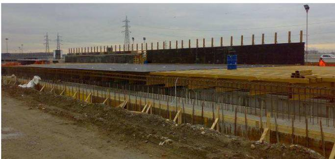
Figura 10 – Realizzazione del muretto di varo sud e disposizione dei casseri.
