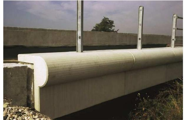
Figure 15 e 16: Casseforme per il getto della soletta
