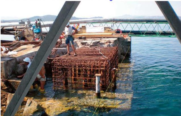
*Sistema di casseratura dell'arco inferiore*
