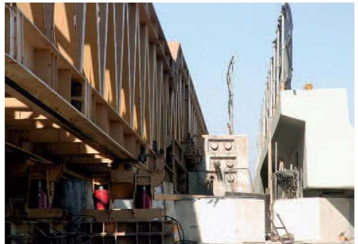
*Fase finale di spinta del secondo solettone; in primo piano i pattini idraulici*
