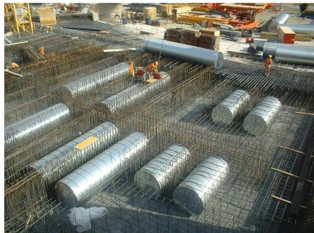
Particolare della posa delle armature della platea della Torre C.
