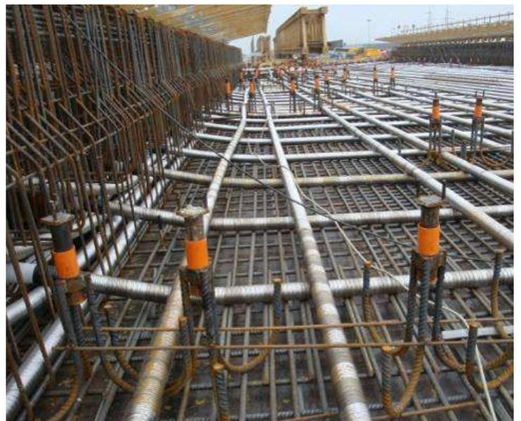
Figura 12 – La disposizione delle guaine dei cavi di precompressione con vista degli ancorotti degli avambecchi di varo
