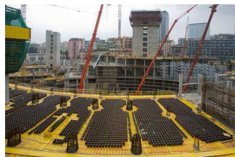
Solaio alleggerito con sfere in polietilene tipo Cobiax
