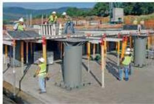
FASE 9\_ Predisposizione delle puntellazioni di sostegno del piano di casseratura della soletta superiore
