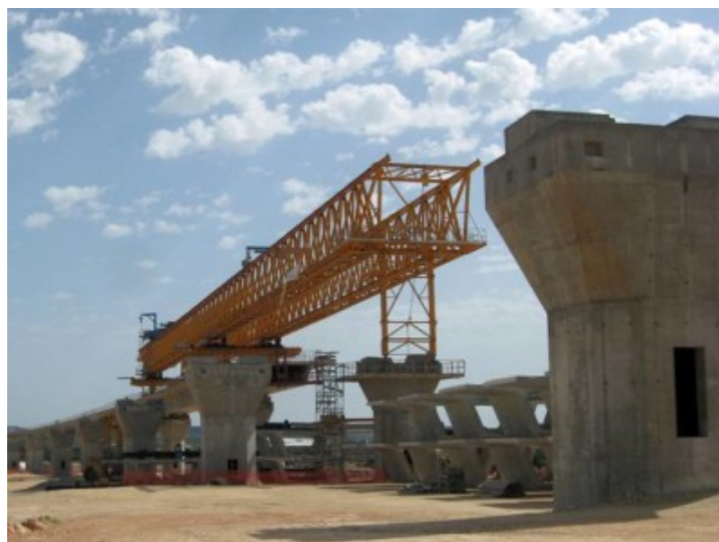
Fig.1 Viadotto Salvia - attrezzatura di varo riposizionata sulla pila in avanzamento
