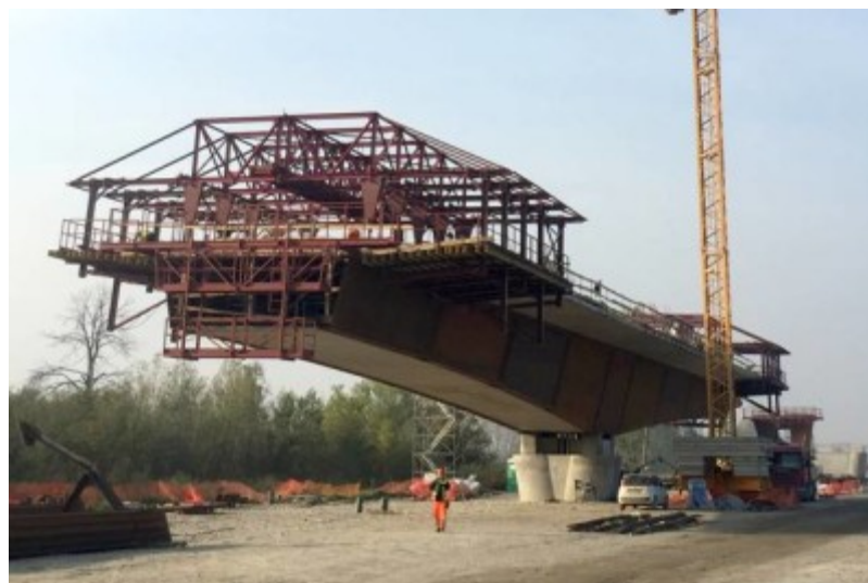
Fig.9 Viadotto Taro - vista dell'impalcato in costruzione
