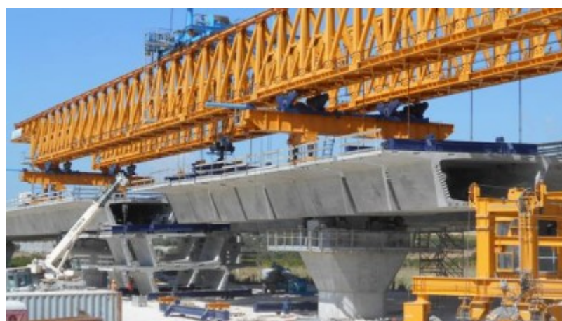
Fig.3 Viadotto Scardina - appensione dei conci all'attrezzatura di varo
