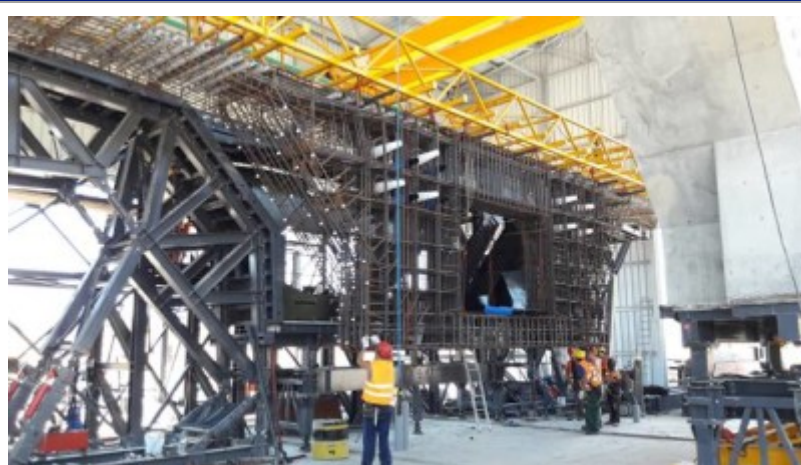
Fig.7 Nuovo Ponte sul fiume Tagliamento - una fase di realizzazione del concio di testa pila
