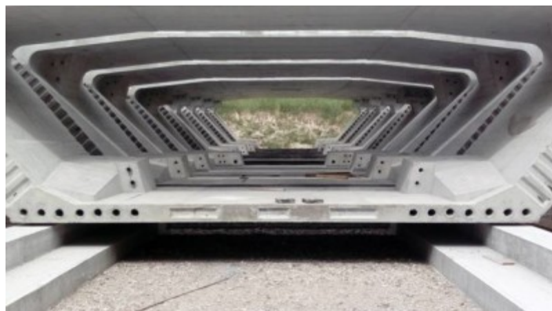
Fig.8 Nuovo Ponte sul fiume Tagliamento - vista dei conci nell'area di stoccaggio
