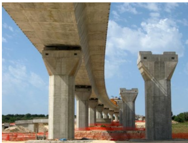
Fig.4 Viadotto Salvia - vista dell'opera in costruzione
