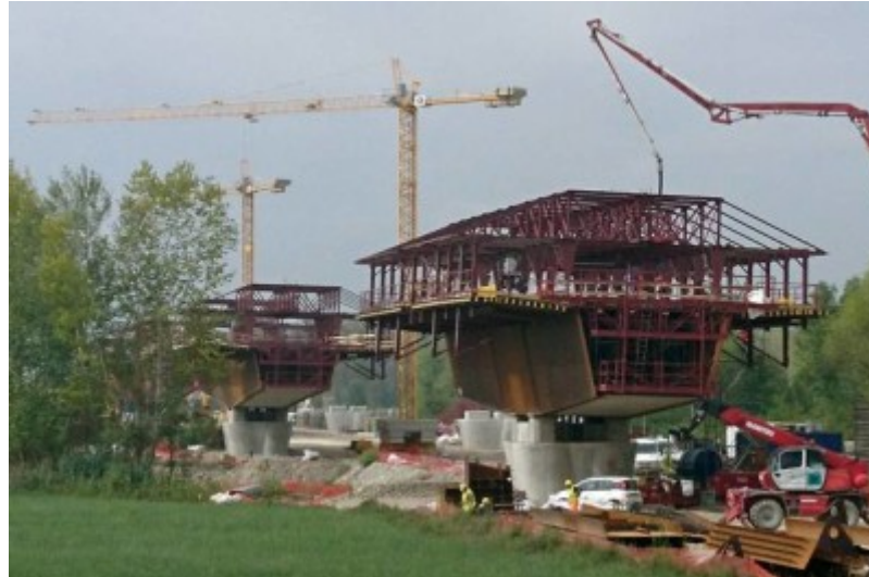
Fig.10 Viadotto Taro - vista dell'impalcato in costruzione
