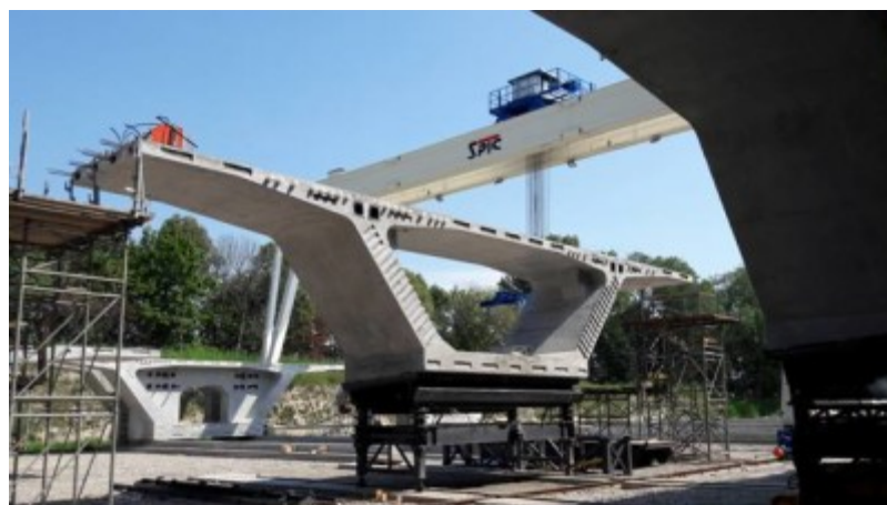
Fig.5 Nuovo Ponte sul fiume Tagliamento - stabilimento di prefabbricazione: concio tipo completato
