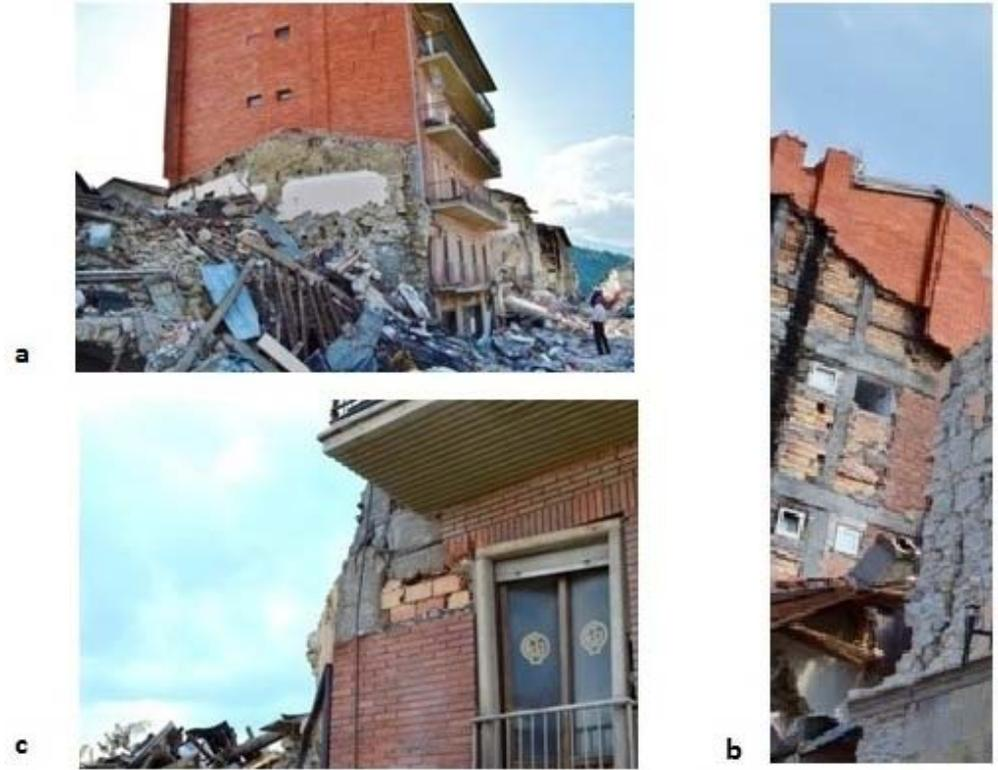
Figura 10: a) Danni subiti dalle tamponature ortogonali al corso Umberto I; b) danni subiti dalle tamponature ortogonali al corso Umberto I con evidente distacco dell'involucro esterno in mattoni rossi; c) dettaglio danni nel nodo in c.a. al primo piano.
