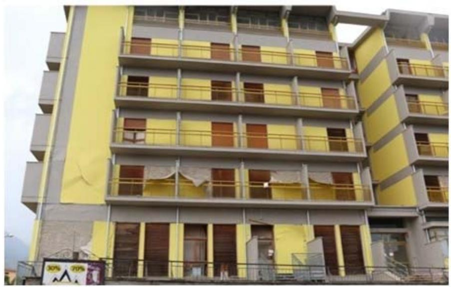
Figura 12: Edificio in c.a. evidenziato in Figura 7 post evento sismico (da [3]).
