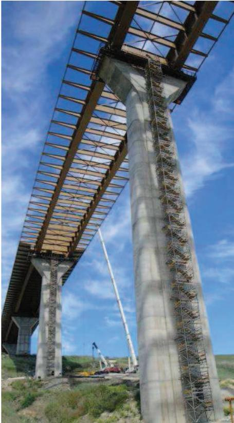
La distorsione è consistita nell'imporre un innalzamento di 42 cm prima della saldatura centrale e un abbassamento di 42 cm dopo la saldatura
