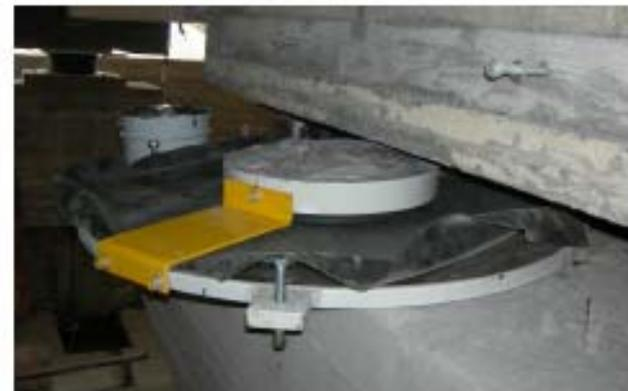
Figura 17. Particolari isolatore a scorrimento (sopra) e preliminarmente alla fase di posa
