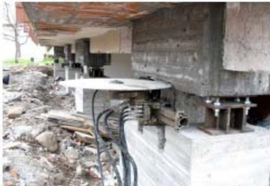
Figura 12. Fase preliminare al taglio mediante disco diamantato
