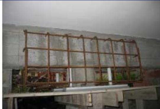
Figura 10. Armatura e dima ringrosso superiore
