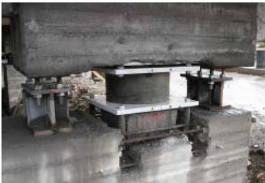
Figura 14. Posa isolatore con serraggio alla piastra superiore
