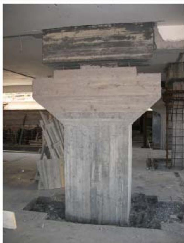
Figura 16. Ringrosso superiore ed inferiore dei pilastri centrali per posa isolatori a scorrimento
