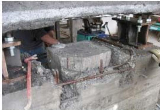
Figura 13. Fase successiva al taglio con struttura poggiate su dispositivi di contrasto temporaneo
