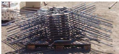
Edificio principale: attacchi nuclei solette a/c - pezzi prima della saldatura
