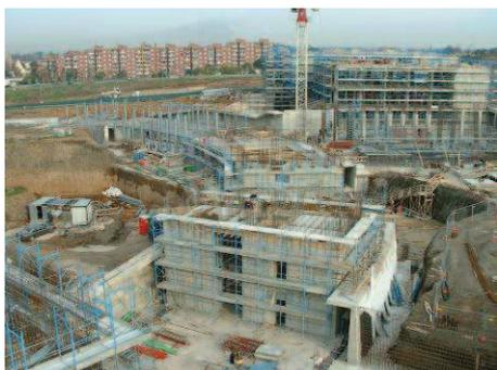
In questo modo si è potuto garantire la regolarità della risposta strutturale all'azione sismica, senza ricorrere a nuclei irrigiditi.
