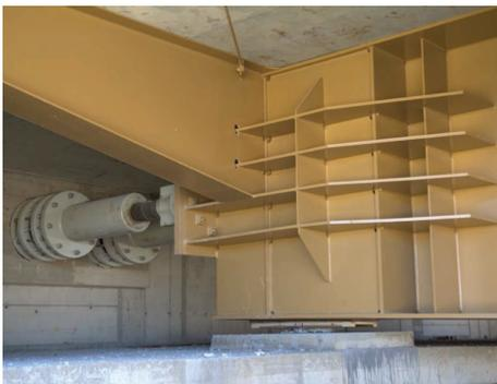
Dispositivi di ritegno elastico da 4000 KN e dispositivi da 4000 KN accoppiati a shock transmitter
