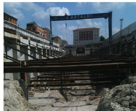
Figura 11 - I diversi ordini di puntoni metallici in fase di scavo
