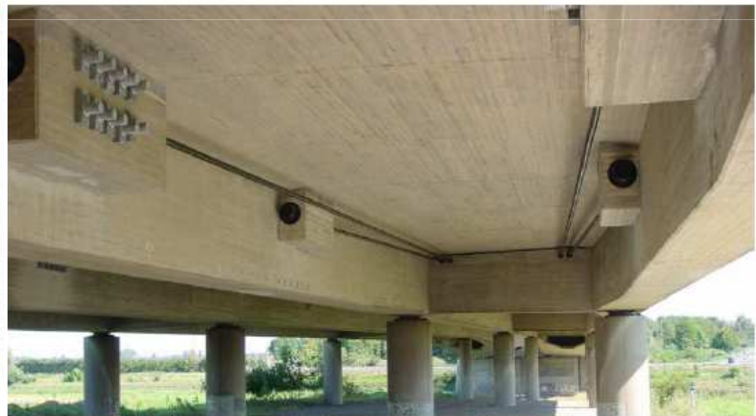
Figura 8. Rinforzo longitudinale con cavi esterni
