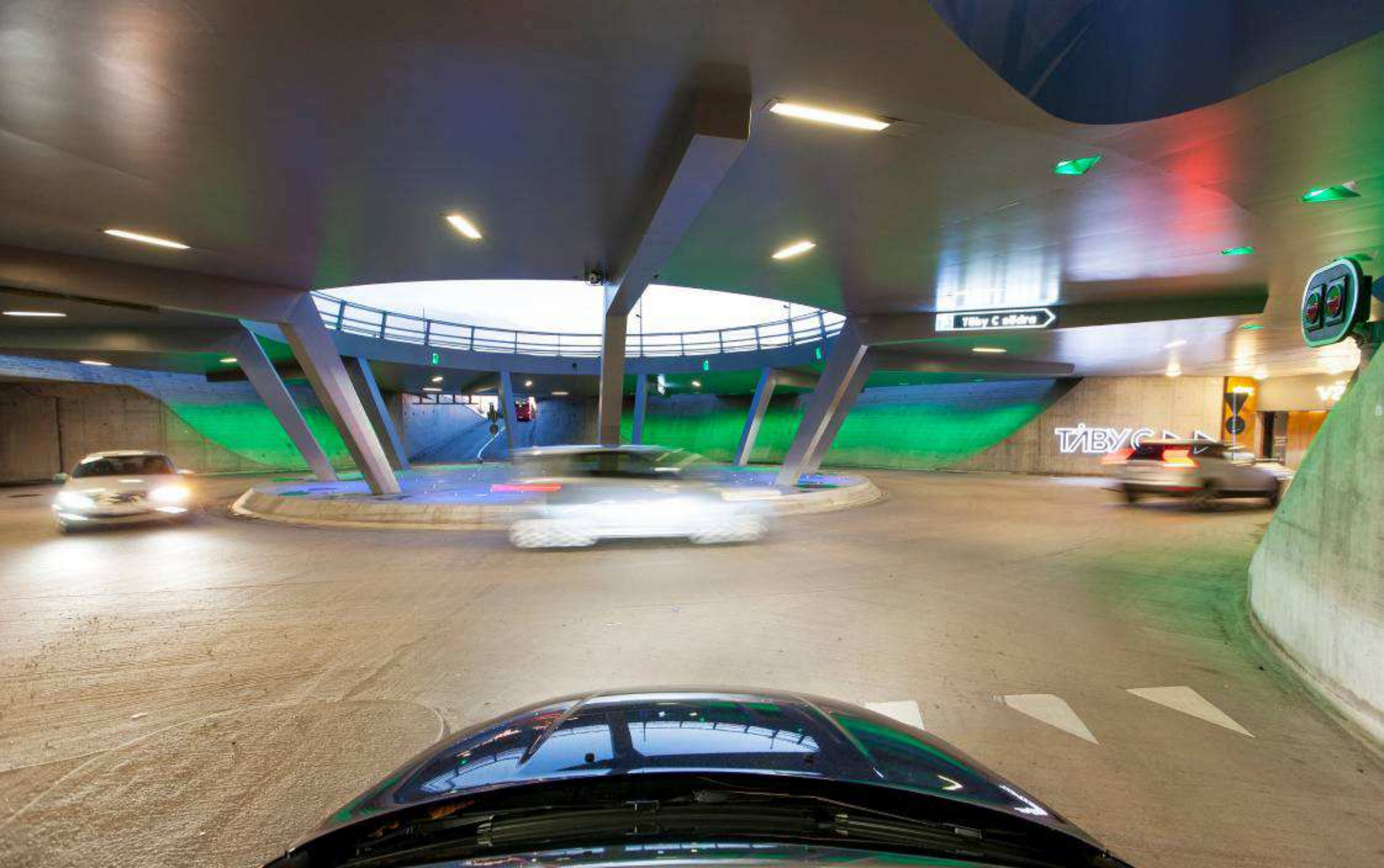
ROUNDAABOUTS IN TÄBY CENTRUM
