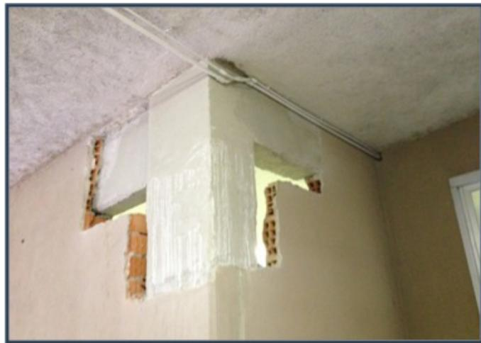
Figure 3 - Surface preparation / Preparazione della zona di intervento
