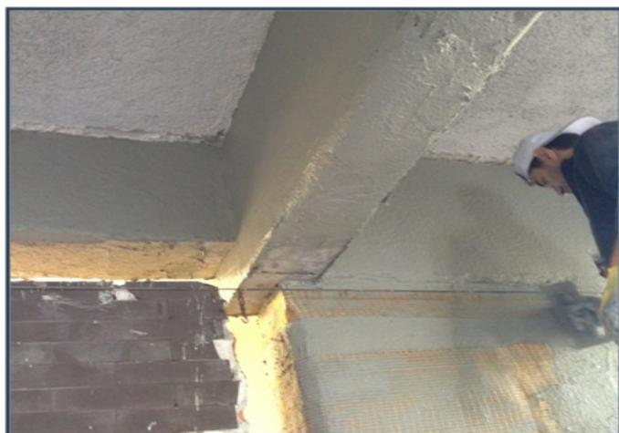
Figure 4 - Application of PBO-FRCM on beam-column joint / Fase esecutiva dell'intervento sui nodi con FRCM
