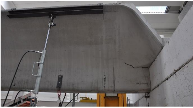
Figure 12. The marked horizontal crack developed at the element ends for shear-hang starting from the section of discontinuity / La fessura orizzontale evidenziata si è sviluppata all'appoggio per taglio-appensione a partire dalla discontinuità del cambio di sezione.
