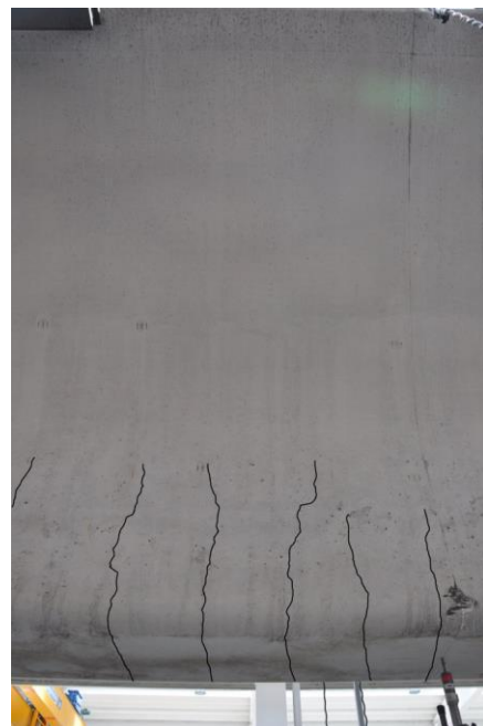
Figure 11. Marked crack pattern for flexure in element the mid-span region, distributed according to the stirrup spacing / Fessurazione evidenziata distribuita con il passo delle staffe per flessione nell'intorno della mezzeria dell'elemento.
