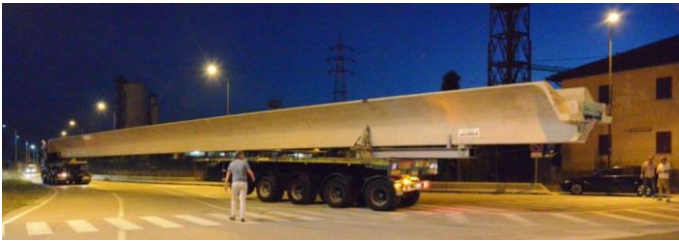
Figure 4. BigOndal element in phase of transportation / Elemento BigOndal in fase di trasporto.
