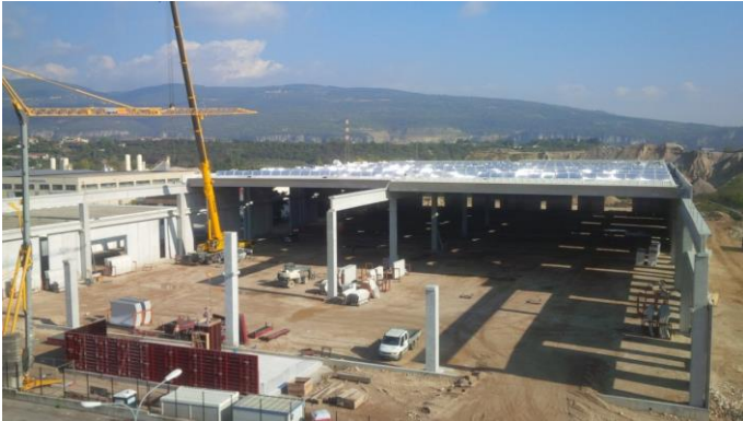
Figure 5. Assemblage of a precast industrial building with the BigOndal roof system / Assemblaggio di un edificio prefabbricato con copertura tipo BigOndal.
