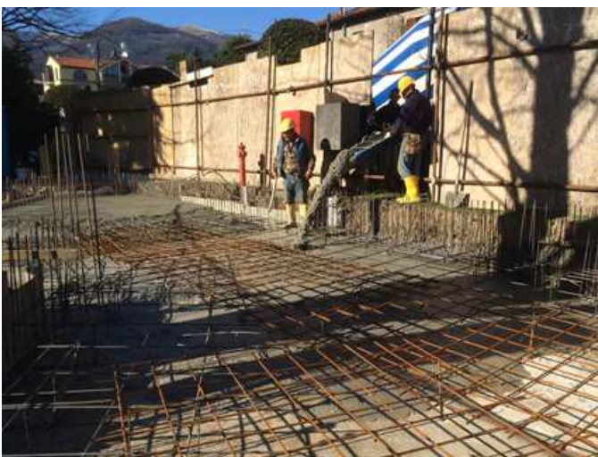
Figure 7. Casting of the elevated slab / Getto della piastra di copertura del piano interrato.
