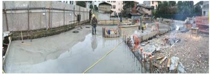
Figure 8. Curing conditions of the casting carried out with water flooding of about 2 cm / Condizioni di maturazione del getto con allagamento superficiale di circa 2 cm.
