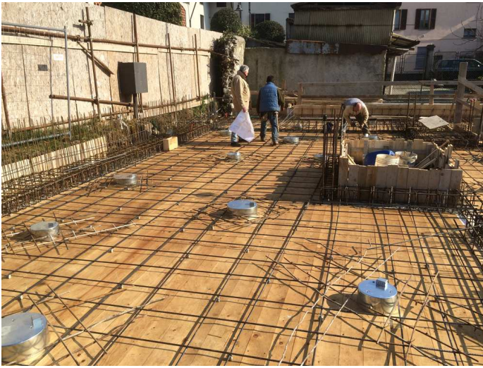
Figure 5. Reinforcement disposal in the elevated slab/ Disposizione dei ferri d'armatura nella piastra di copertura del piano interrato.
