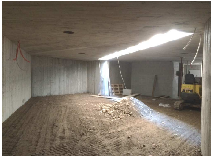
Figure 9. Vista dal piano interrato dell'intradosso della piastra in SFRC / View from the basement of the intrados SFRC plate.
