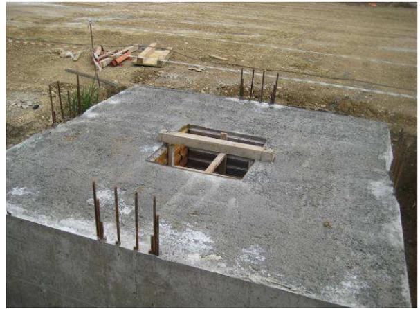
Figura 6 – Plinto di fondazione con bicchiere indentato
