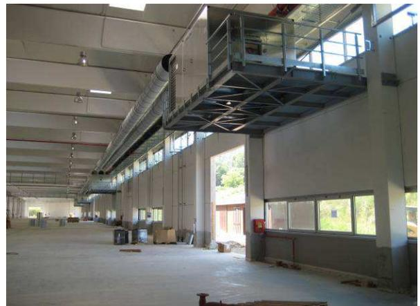
Figura 13 – Ballatoi metallici a sbalzo da pilastri
