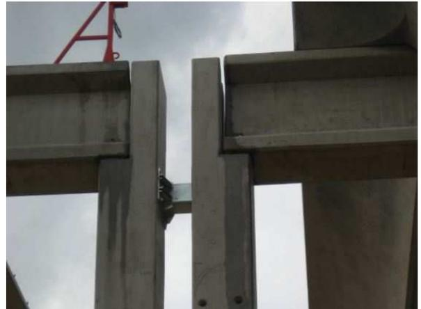
Figura 12 – Giunto sismico
