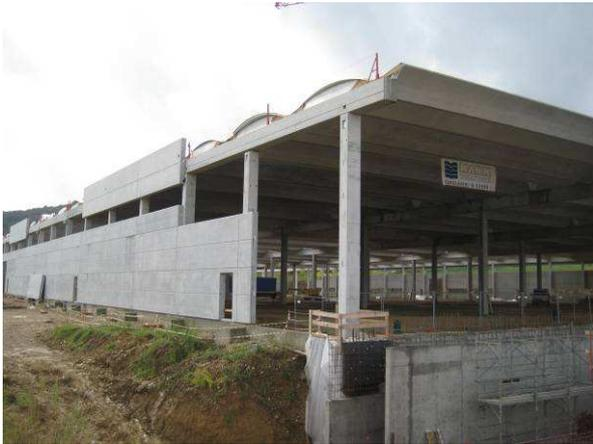
Figura 9 – Struttura con pilastro intermedio
