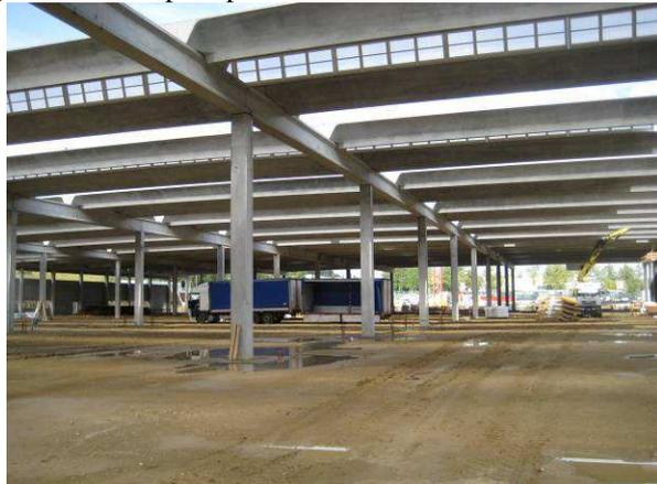
Figura 8 – Struttura prefabbricata
