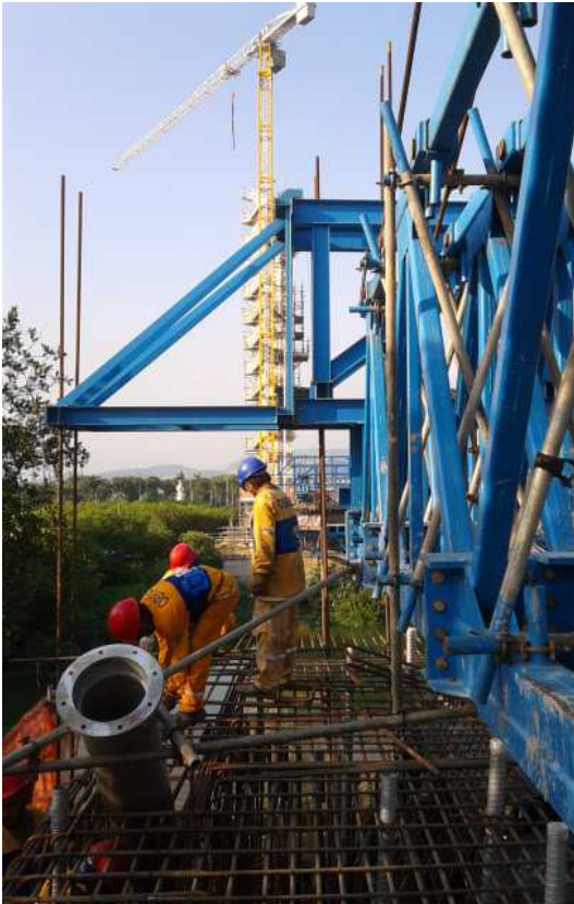
Figura 14. Trave longitudinale armata e tubo forma / Longitudinal beam and casing pipe
