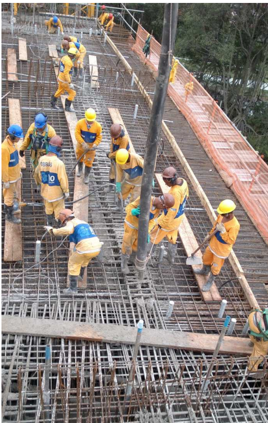
Figura 15. Getto della trave trasversale dell'impalcato / Transversal beam casting
