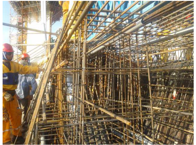
Figura 6. Armatura della soletta e traliccio che sostiene il cassero / Deck reinforcement and launching formwork truss
