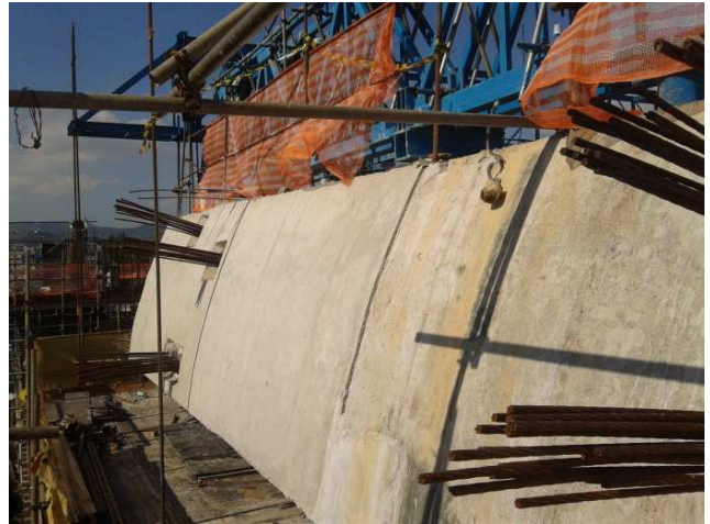
Figura 16. Vista della trave longitudinale e dei cavi / Lateral view of the longitudinal beam and transversal cables
