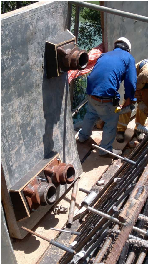
Figura 4. Cassero con ancoraggi dei cavi trasversali / Deck lateral formwork with transversal cable anchorages
