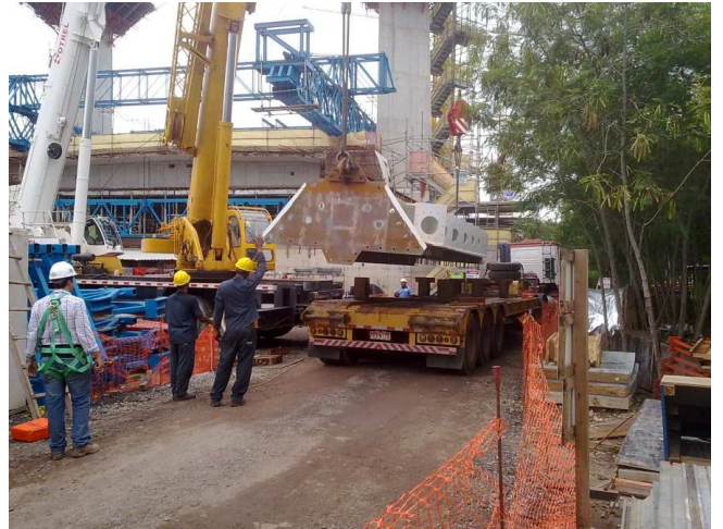
Figura 10. Sollevamento dell'elemento metallico con autogrù / Steel tower element lifting with crane
