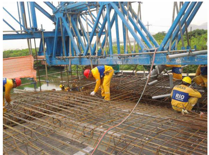
Figura 7. Armatura della trave longitudinale / Deck longitudinal beam reinforcement
