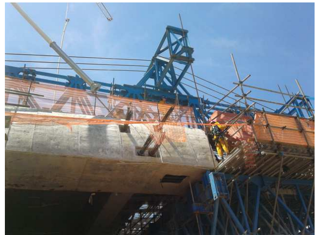
Figura n. 17. Avanzamento della trave e cavi trasversali./ Launching formwork advancing and transversal cables
