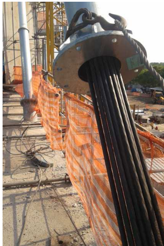
Figura 12. Fase di installazione dei trefoli sull'impalcato. Il tubo anti vandalismo rimane sollevato per permettere il passaggio dei trefoli / Stay Cable installation
