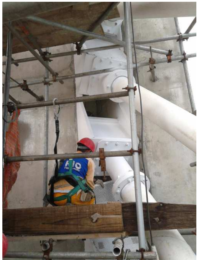
Figura 11. Opere di finitura sugli elementi metallici delle antenne / Finishing on steel towers elements
