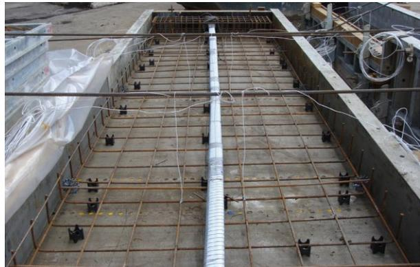
Figura 3.2. - Armatura del campione prima del getto
