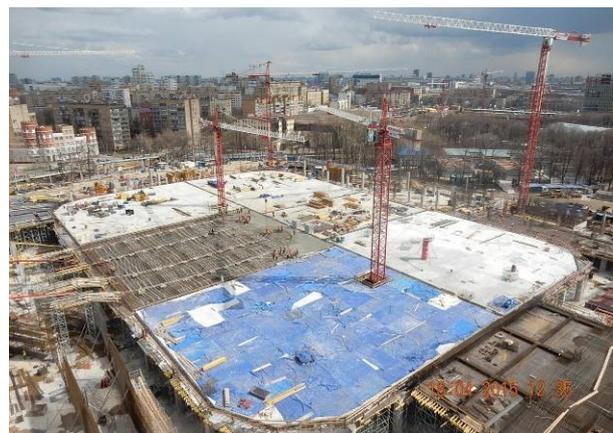
Figura 5.2 - Immagine del solaio in fase di realizzazione in cui si notano le suddivisioni in conci.
