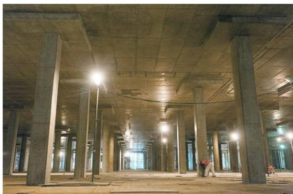
Figura 8.1 - Le strutture del pitch scasserate con i giunti resi definitivi
