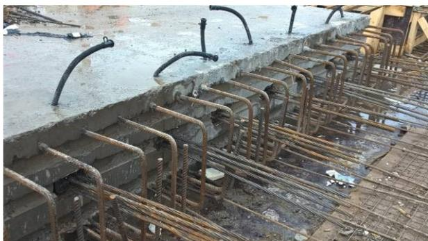
Figura 5.4 - Immagine del bordo di solaio al termine della fase 1
