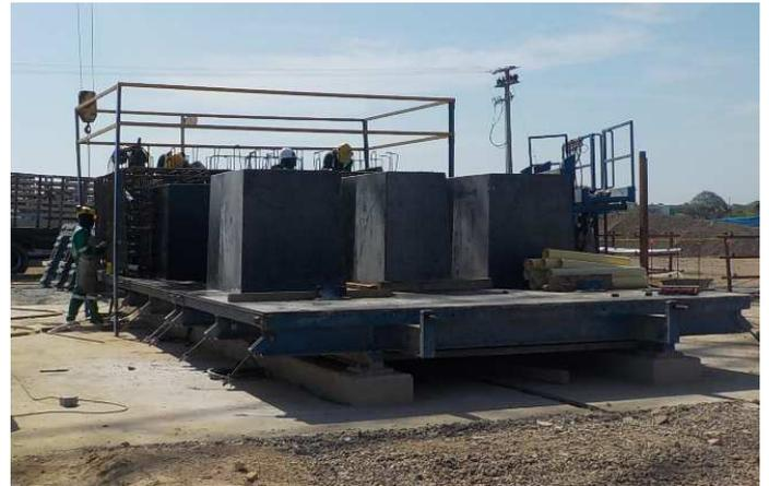
Figure 6. Pile cap mould / Cassero per la prefabbricazione del pulvino.
