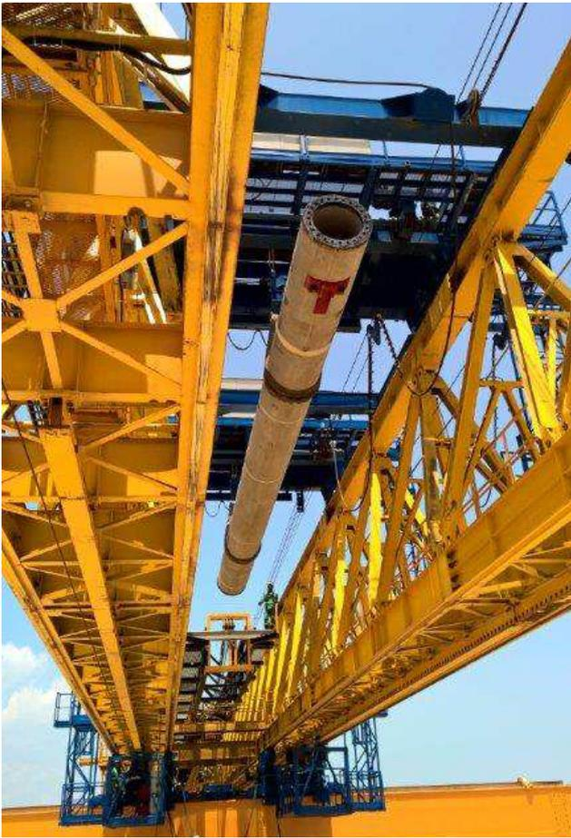
Figure 13. Relocation of pile by means of winches / Argani durante il trasporto del palo alla guida.
