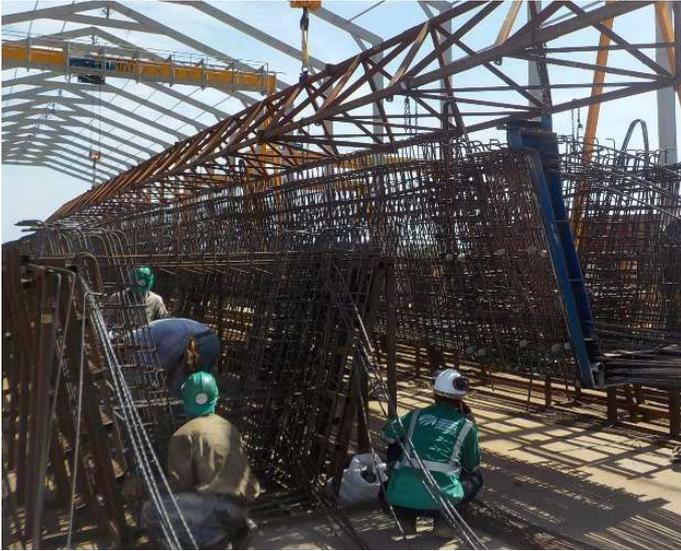
Figure 8. Beam rebar jig for the assembling of beam reinforcement / Dima per il preassemblaggio delle armature delle travi.
