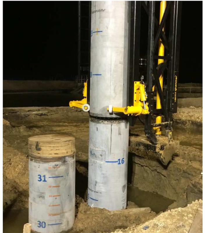
Figure 23. Connection of the second pile to the first pile / Collegamento del secondo palo con il primo palo.
