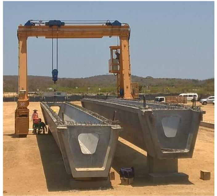
Figure 10. Stocking of precasted beams / Travi prefabbricate stoccate nell'area di finitura.
