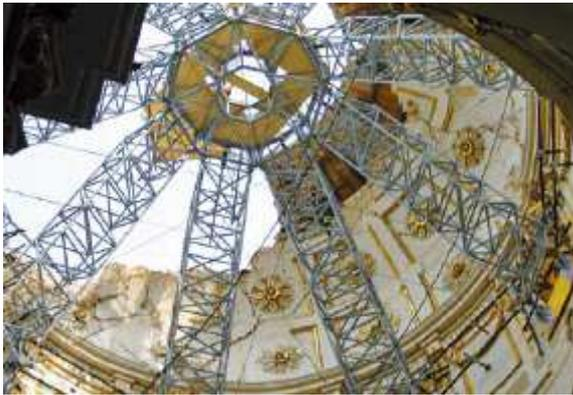
Figura 16 - Intervento di tirantatura e ritegno di volta.
