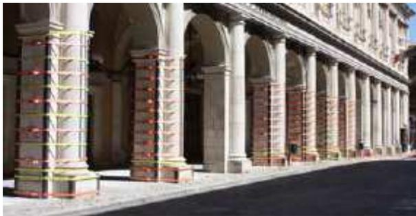
Figura 11 - Intervento di cerchiatura con fasce di poliestere.
