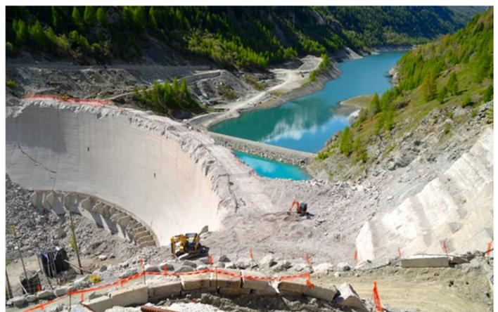
Figure 10. Beaugard dam: partial demolition of the upper part / Diga Beaugard (CVA – AO): parziale demolizione della parte alta, 2013-2015.
