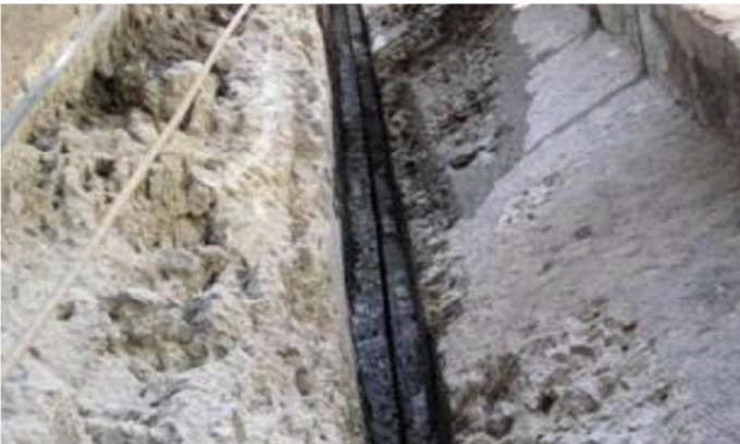
Figure 8. Poglia dam: cut of the structural joint / Diga Poglia (EDISON – BS): taglio del giunto strutturale, 2005.
