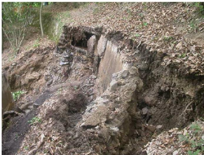
Figure 11. Sliding of a channel / Cedimento di un canale.
