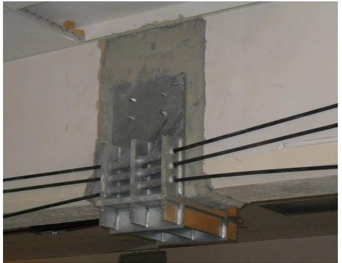
Figure 3. Deviation saddle and cables at first tensioning / Sella di deviazione con cavi di prima tesatura.
