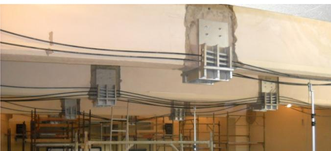
Figure 2. Auditorium: Deviation saddles before of the tensioning steps. / Disposizione delle selle di deviazione nella fase precedente la tesatura.
