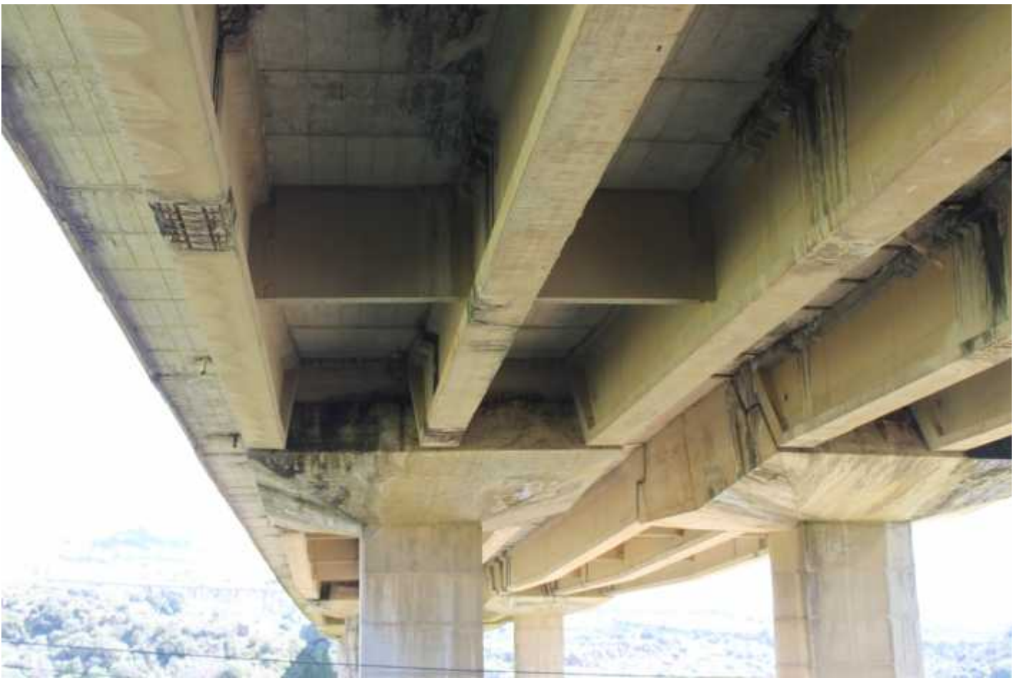
Figure 2. Bottom view of the deck consisting of 3 prestressed concrete beams / Vista inferiore dell'impalcato costituito da 3 travi in cemento armato precompresso
