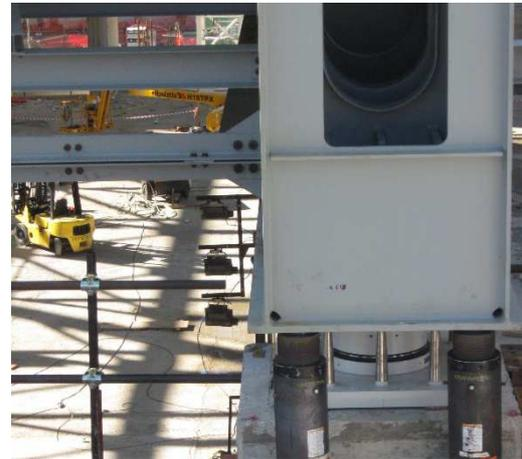
Figure 6: Steel beam seismic disconnection detail / dettaglio della sconnessione sismica delle travi metalliche
