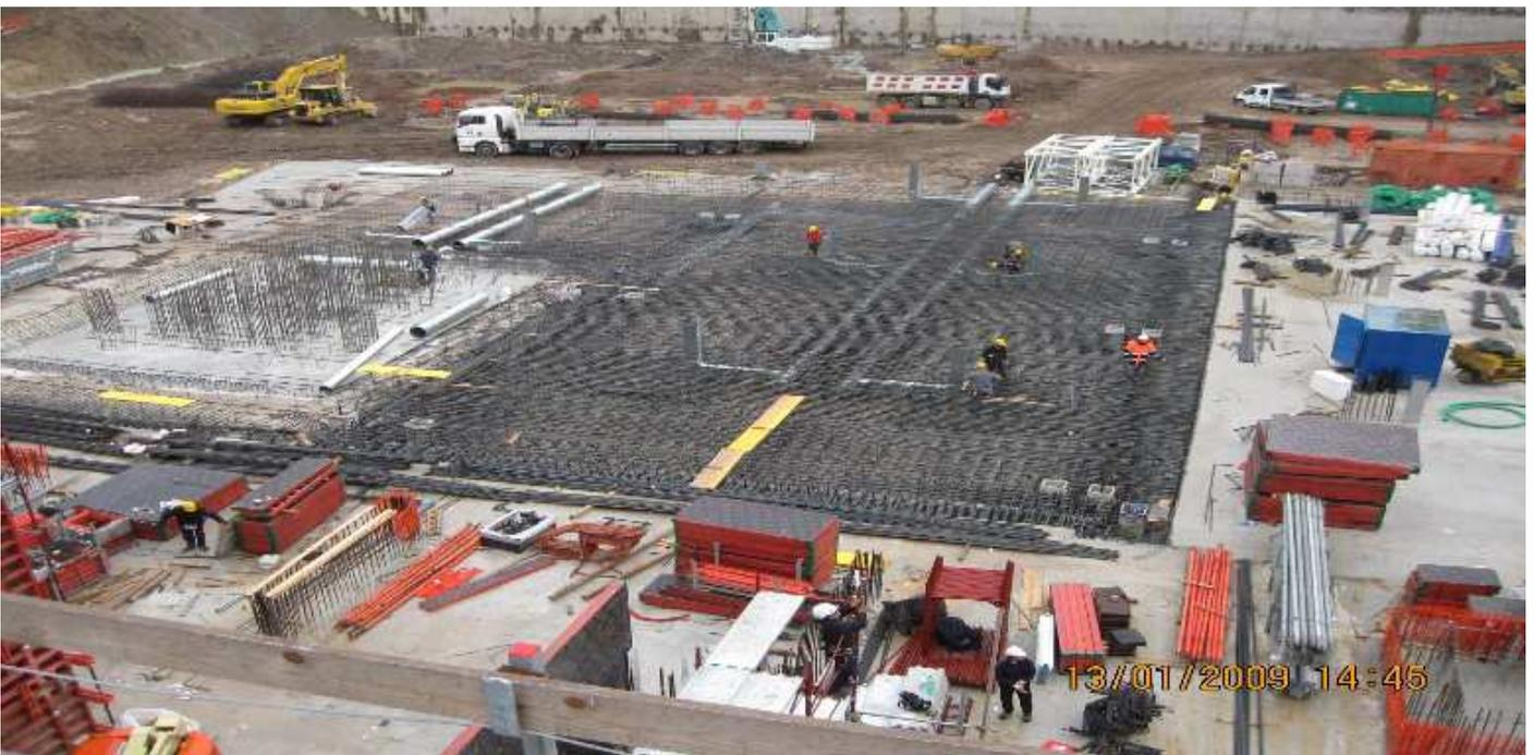
Figure 4: smoke extract ductwork systems within the foundation slab / Sistema di estrazione fumi all'interno della soletta di fondazione
