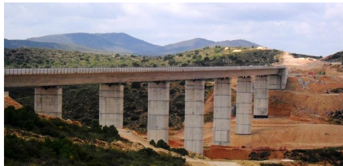
Foto 1 – Il viadotto n. 12 della SMS
