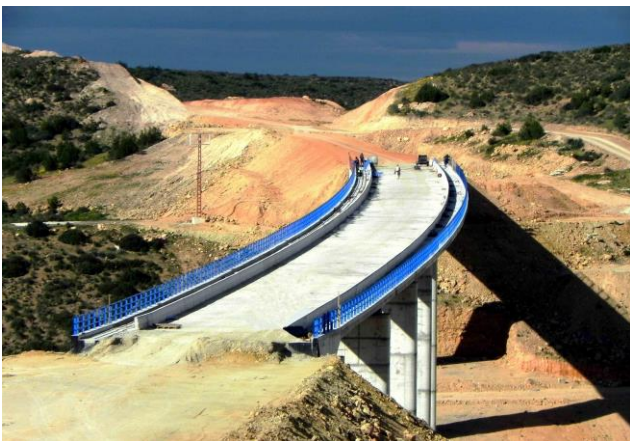
Foto 10 – Vista con la curvatura del viadotto
