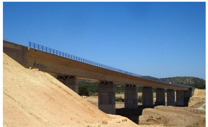
Foto 11 – Il viadotto ferroviario ultimato
