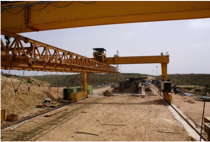
Foto 3 – Campo di prefabbricazione e spinta Picture 3 - Prefabrication and launch yard
