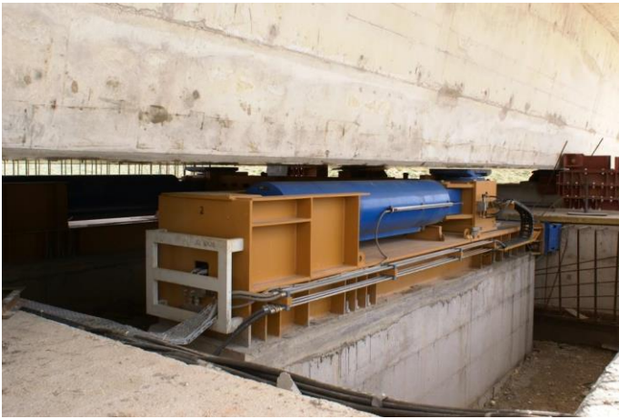
Foto 7 – Martinetto di spinta Picture 7 - Hydraulic jack
