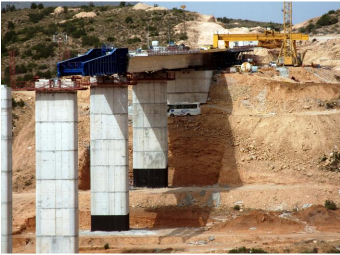
Foto 2 – Viadotto in avanzamento Picture 2 - Viaduct works in progress
