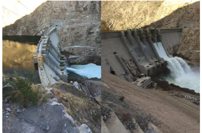
Fig. 21 – Scarichi di fondo e sfioratore in funzione / Bottom outlets and spillway during operation
