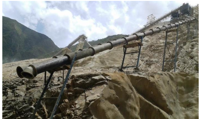
Fig. 7 – Tubazione in acciaio, punto di scarico / Steel pipeline outlet
