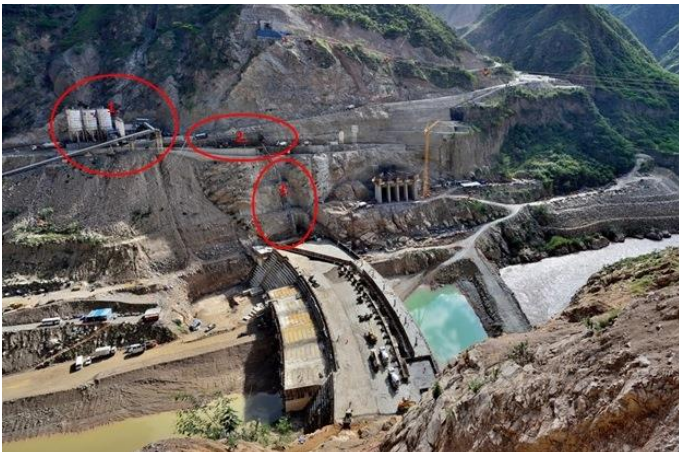
Fig. 5 – Vista generale - 1. Impianto di calcestruzzo – 2. Nastri trasportatori e tramoggia – 3. Linea tubazioni / Overall view 1. Concrete mixing plant - 2. Conveyor belts and hopper - 3. Pipeline
