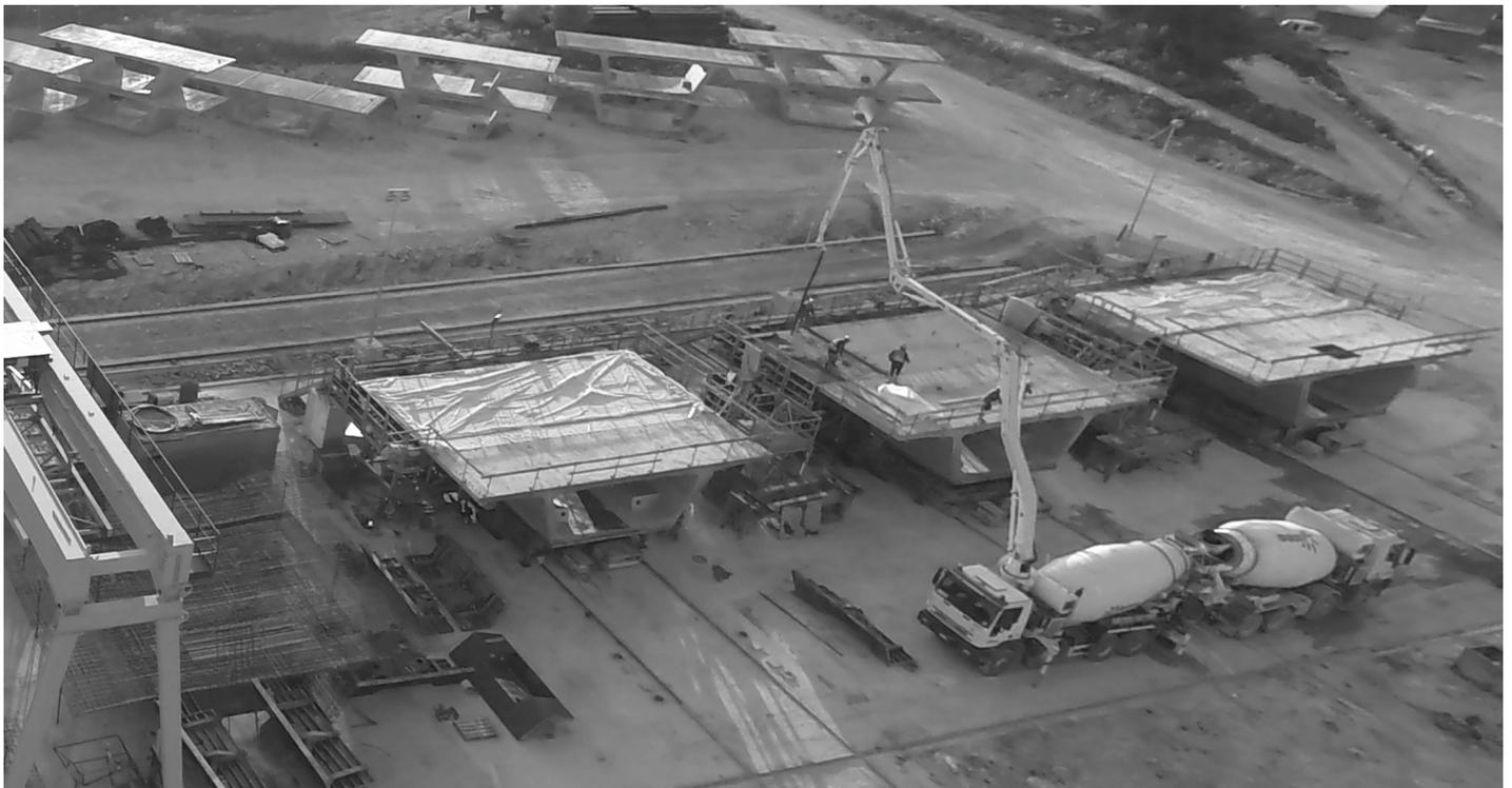
Figure 1. Precast segment fabrication lines / Le tre linee di prefabbricazione.
