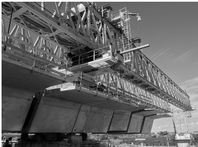
Figure 4. Cantilever precast segments / Conci a sbalzo dalla pila.
