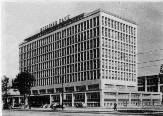
FIG. 15. — Edificio senza pilastri intermedi al piano terra, in cemento armato precompresso.
