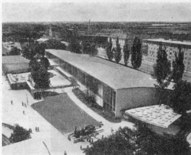
FIG. 14. — Sala da esposizione, Monaco: volta a guscio precompressa: raggio di curvatura  $m$  75.
