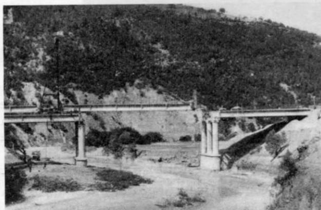
FIG. 6. — Posa di una travata del ponte sull'Oued-Djer.
