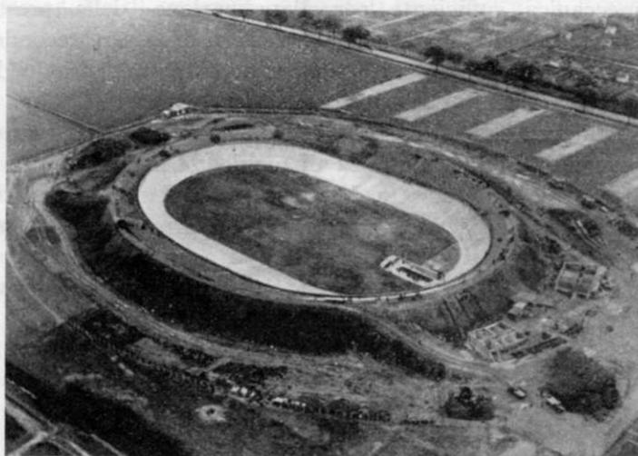
FIG. 18. — Pista ciclistica di Bielefeld: soletta in cemento armato precompresso senza giunti.
