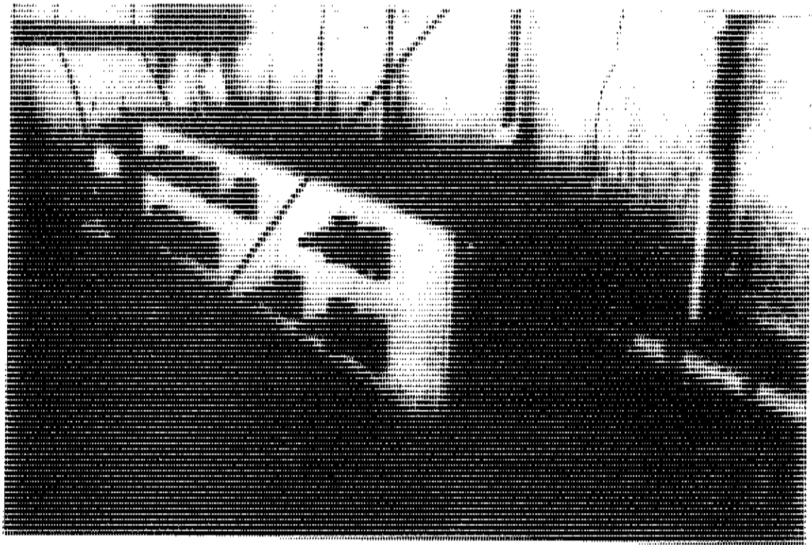
Massif d'ancrage fixé par précontrainte transversale
