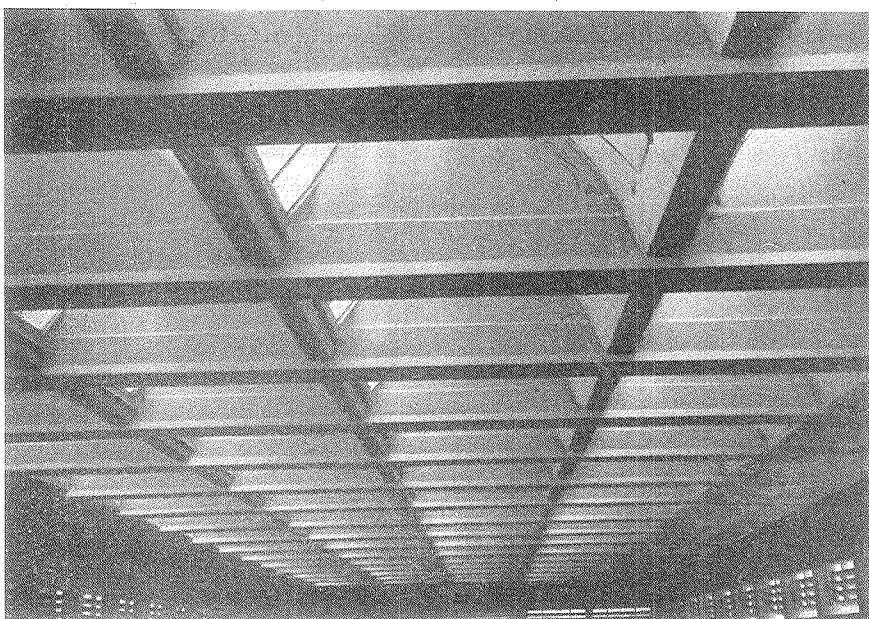
Fig. 1. — Interno di uno dei padiglioni.
