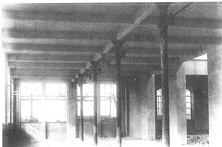
Fig. 14. Solaio in c.a. e pilastri in ghisa.
