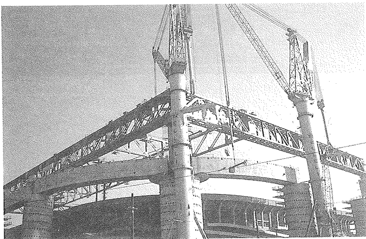
Figg. 66-68-69-70. Prospetto e fasi costruttive dello Stadio Meazza a Milano. Figg. 67-71-72. Fasi di costruzione dello Stadio Bentegodi di Verona.
