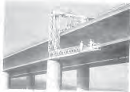
Foto 6 - Ispezione con l'ausilio del by bridge
