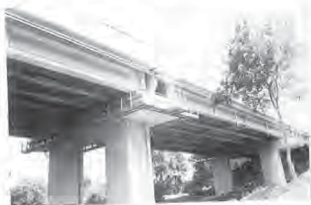
Foto 7 - Dispositivi fissi d'accesso ai pulvini
