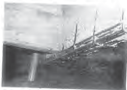
Foto 5 - Disposizione troppo ravvicinata dei ferri
