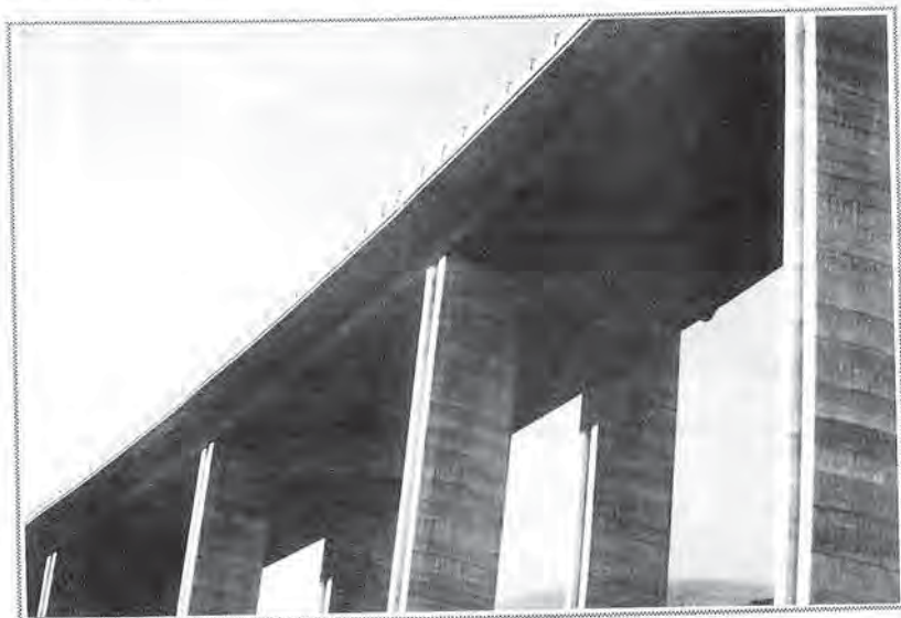
Fig. 3 - Un viadotto (1971-75) della A25 Roma-Pescara: la foto (1990) mostra l'ottimo stato di conservazione della struttura.
