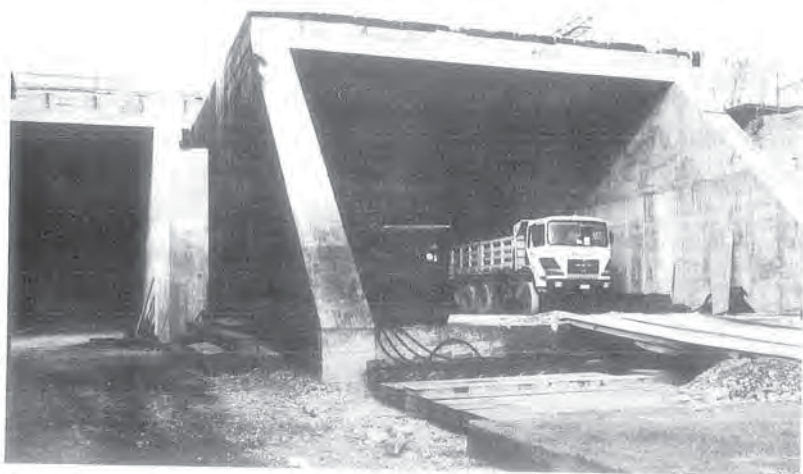
Foto 2 - Monolite scatolare telescopico in fase di spinta con martinetti oleodinamici entro una canna del monolite biscatolare già posizionato sotto la linea F.S. del Brennero.
