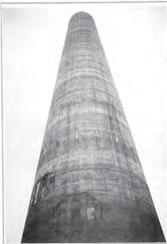
Fig. 6 - La centrale ENEL di Monfalcone (1979): la ciminiera
