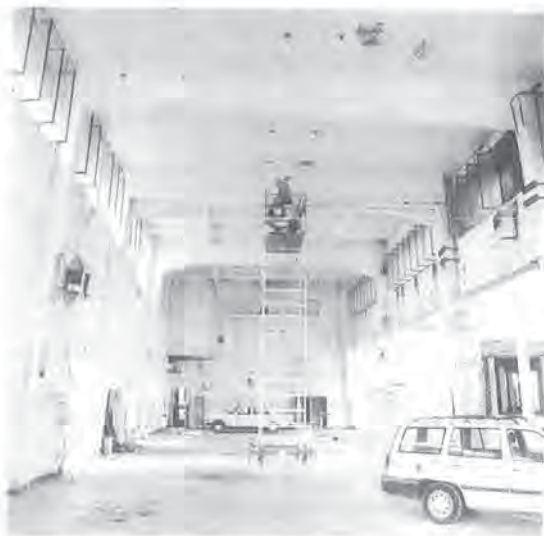
Fig.9 - Indagini ultrasoniche sulle travi di un capannone del corpo fabbrica sud
