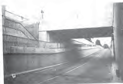
Fig. 15 - Ponte lato Treviso
