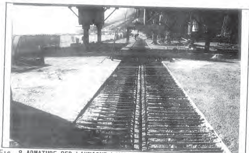
FIG. 8-ARMATURE PER L'UNIONE LONGITUDINALE DEI CASSONI (MATCHING)
