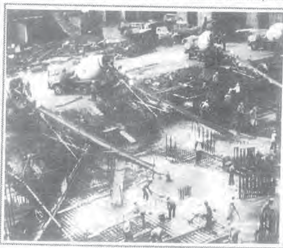
Fig. 11 - Realizzazione di una platea di fondazione con calcestruzzo reoplastico ( Raffles City - Singapore)
