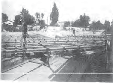
Fig. 10 - Travi di scorrimento
