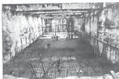
Fig. 8 - Platea di varo Monolite
