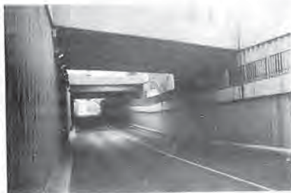
Fig. 14 - Ponte lato Treviso
