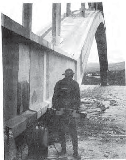
Fig.3 - Vista del ponte e videocamera subacquea
