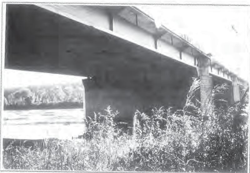
Fig. 2 - Il ponte sul fiume Po a Mortizza (1957-59) come appare oggi
