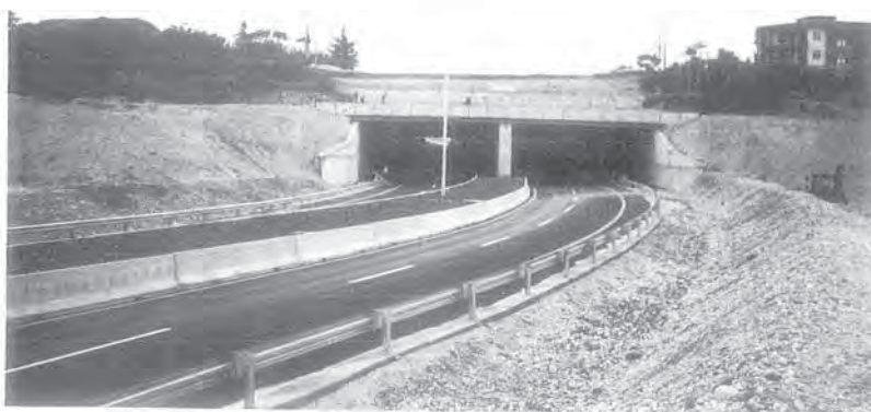
Foto 4 - Panorama dell'imbocco lato Verona della galleria artificiale S. Massimo.
