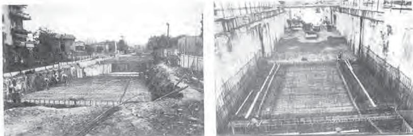
Fig. 6 e 7 - Costruzione rampe a cielo aperto
