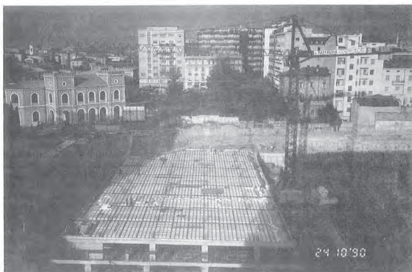
Fig.8 - Secondo impalcato - compartimenti sud
