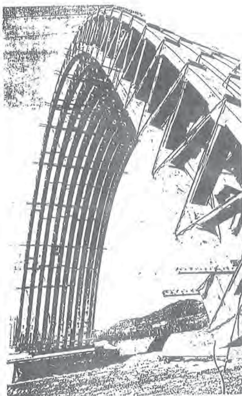
Fig. 5 - Centina per la realizzazione del Viadotto sul Paglia
