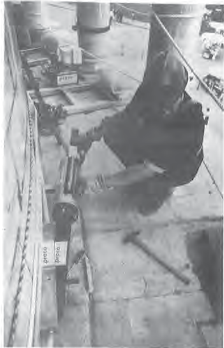
Fig. 2 Particolare della tesatura
