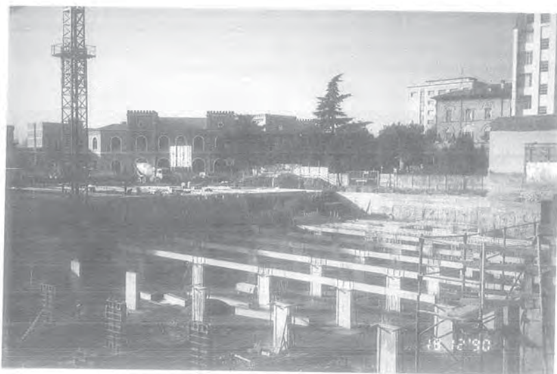
Fig.7 - Pilastri e travi primo impalcato - compartimenti nord
