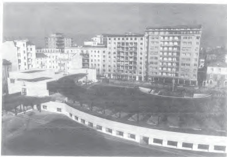
Fig. 1 - Veduta generale dell'impianto da sud
