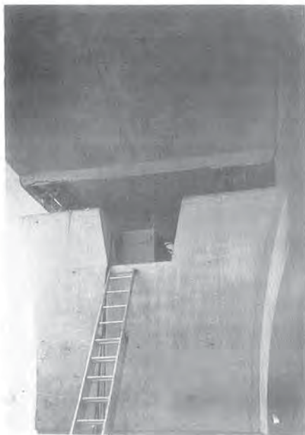
VIA DOTTO COLTANO - Lotto 1 -INSTALLAZIONE CENTRALINA FISSA SU PILA
