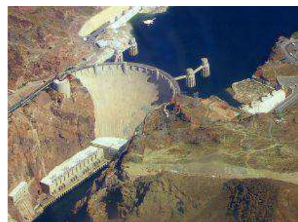
Diga di Hoover sul fiume Colorado realizzata nel 1935
