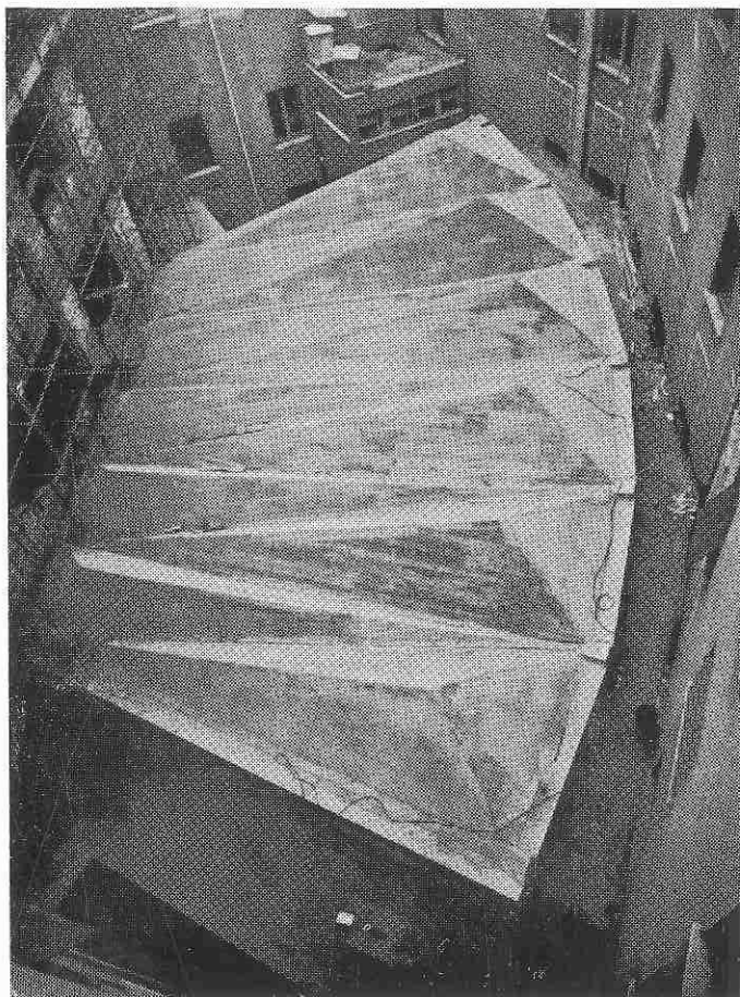
Fig. 8. - La copertura ultimata.
