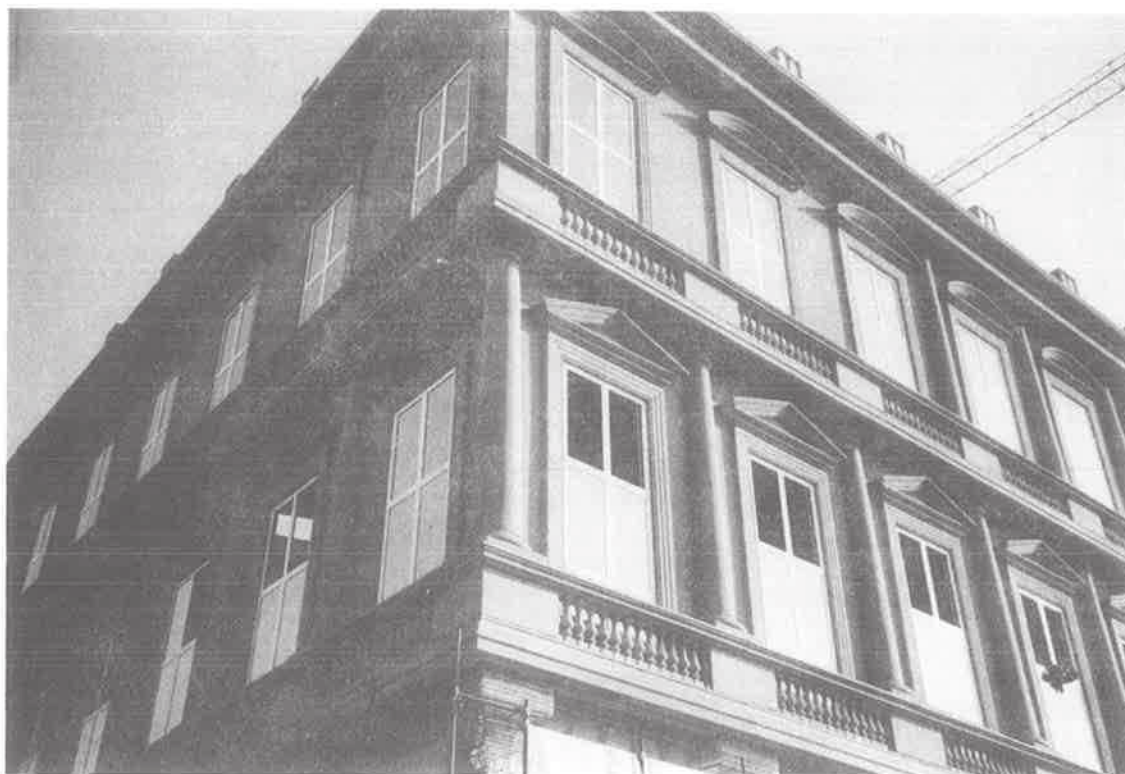
- Edificio in stile - Via Giannoni CASERTA - Impr. Bussiness Fincentre - Prog. Studio Ing. Crispino
