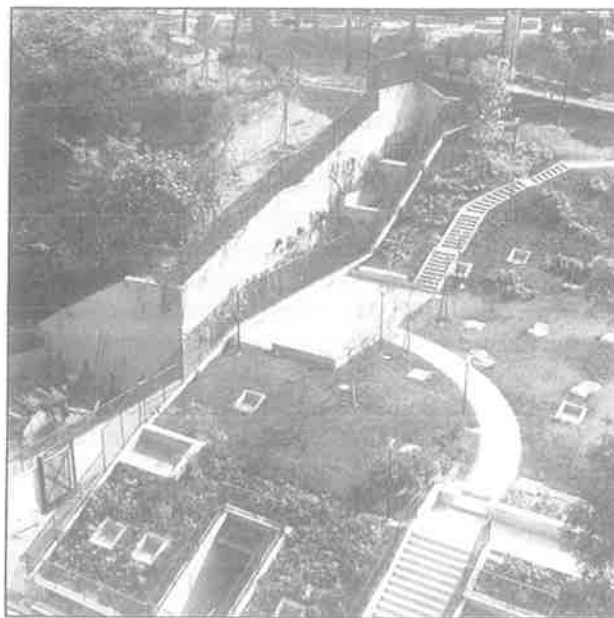
1- Vista del giardino sovrastante la centrale
