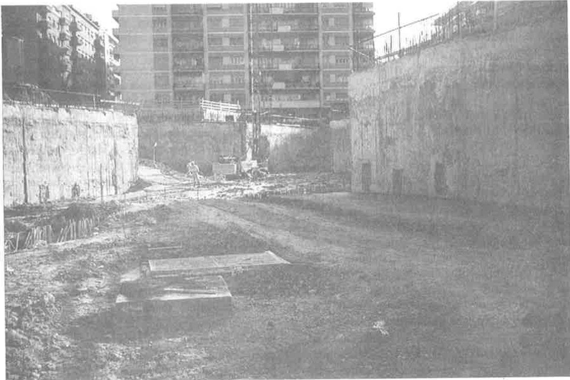
Foto N° 1 - PRIMA DEL GETTO DEL SOLAIO INTERMEDIO
