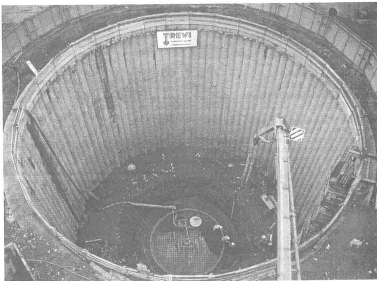
Foto 4 - Diaframma circolare esterno (perimetrale) dell'autosilo
