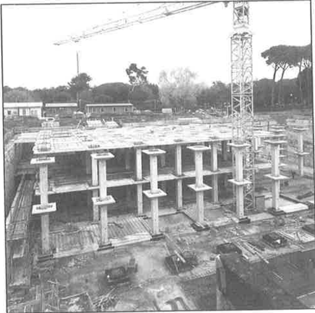
16- Vista d'insieme del cantiere
