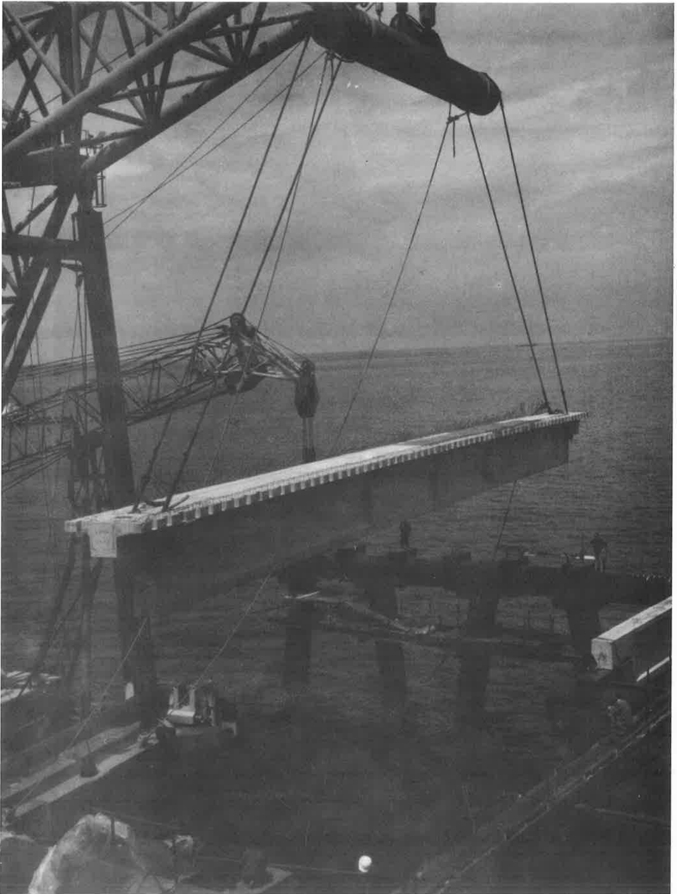
Fig. 5 - Pontile ISAB - Posa delle travi precomprese mediante pontone
