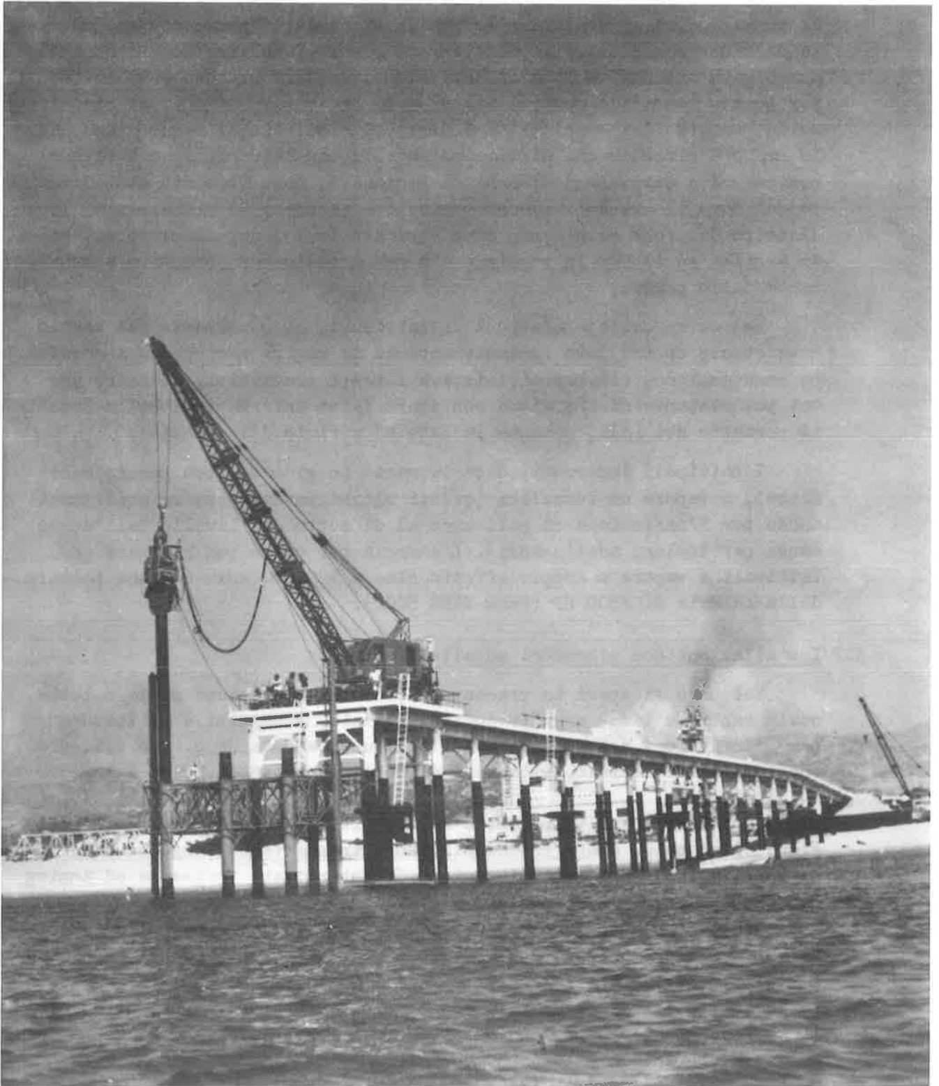
Foto 6 - Pali battuti in acciaio, successivamente trivellati e gettati in calcestruzzo
