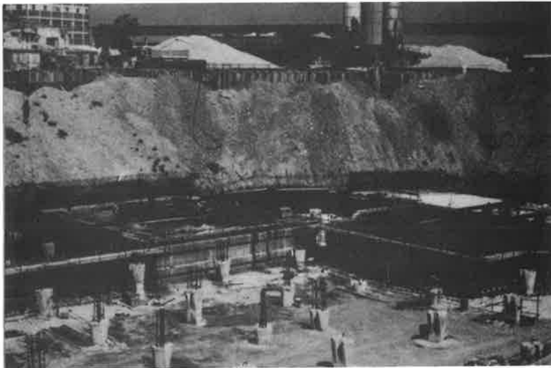
Fig. 27 - Veduta aerea della parte di platea integralmente gettata a cielo aperto. La platea è costituita da con c ci di 1000 \pm 1900 \text{ m}^3 di calcestruzzo.
