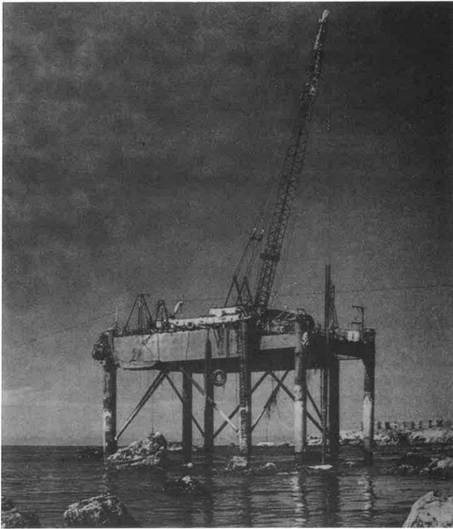
Fig. 5 - Carroponte autovarante (la lavorazione avviene a circolazione inversa previa infissione della camicia definitiva
