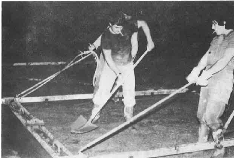
Fig. 29 - Livellamento finale del calcestruzzo mediante staggia vibrante.
