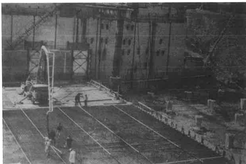
Fig. 23 - Getto a cielo aperto : in alto a destra l'autobetoniera e la pompa dalla quale il calcestruzzo reoplastico scende per essere distribuito attraverso una tubazione.
