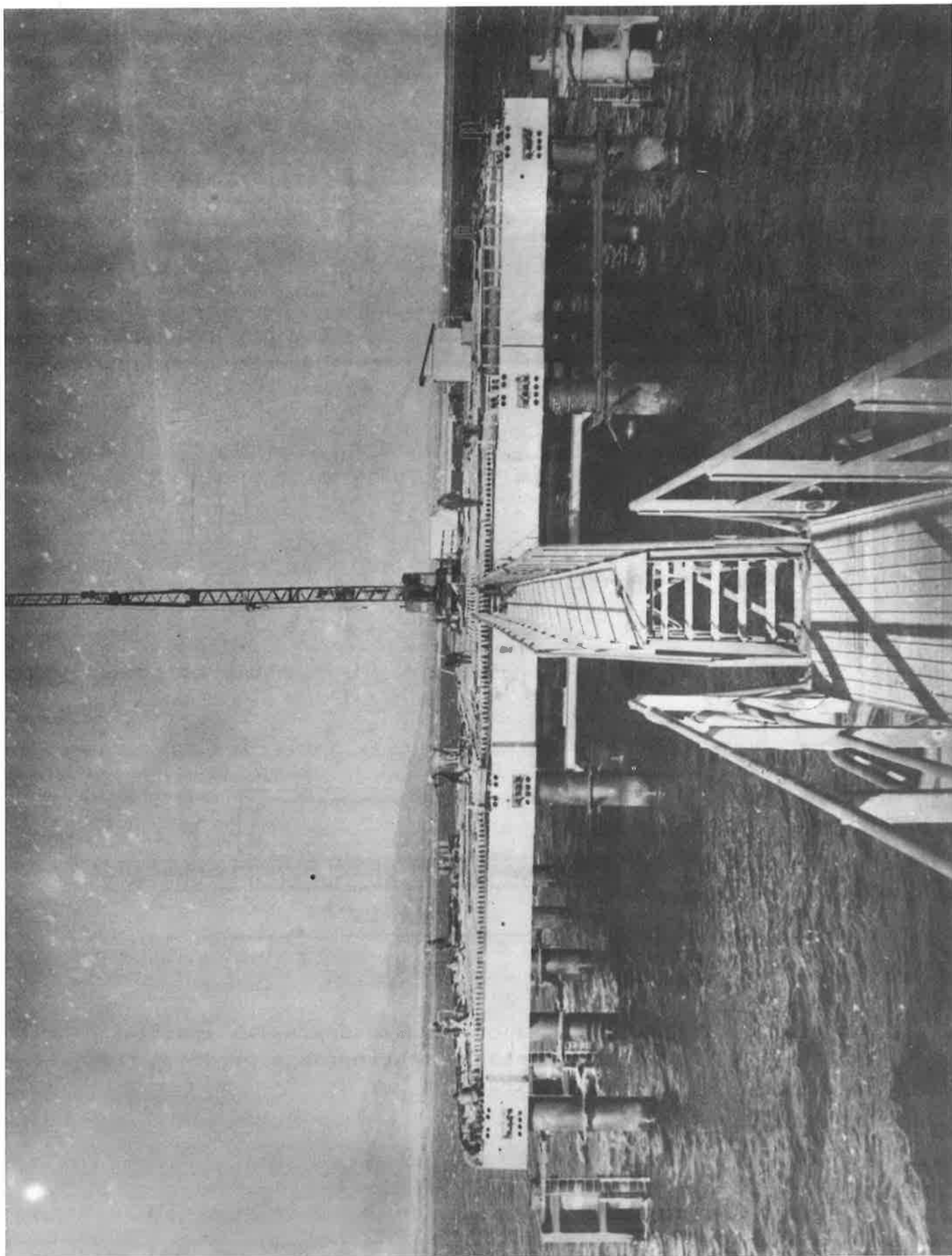
Fig. 16 - Pontile RUMIANCA - Piattaforma prefabbricata pre-compressa
