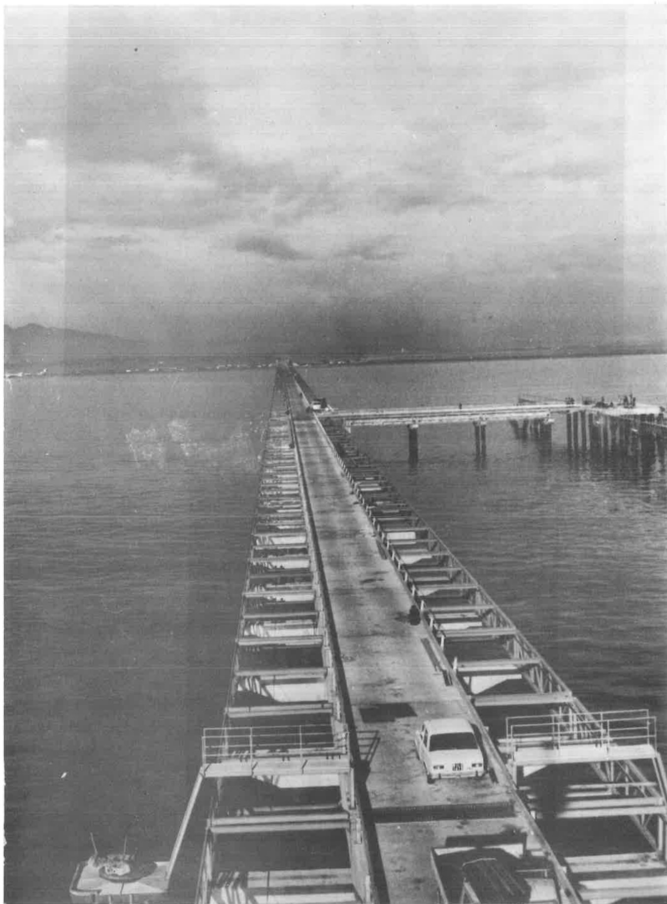
Fig. 15 - Pontile RUMIANCA prima della posa delle tubazioni
