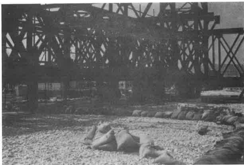
Fig. 6 - I tralicchi in acciaio prima di essere calati sul fondo del mare per essere poi inglobati nel getto di calcestruzzo subacqueo.
