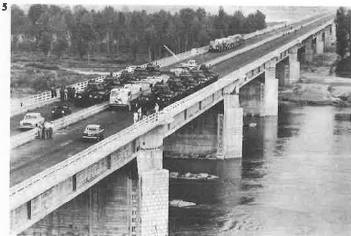
5 - Il collaudo del ponte sul Po dell'Autostrada del Sole, di Zorzi (1939); 6 - Giunti di accoppiamento (da Baur-Göhler [9]). Legenda: a) precompressione della prima sezione; b) getto della seconda sezione; c) geometria delle due sezioni indeformate; d) non uniforme precompressione risultante.
