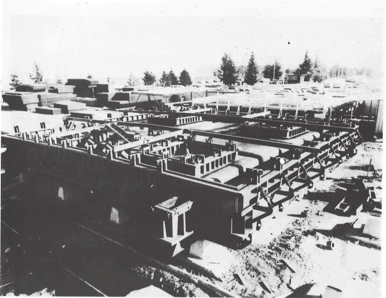
FIG.6 - Il cassero per la prefabbricazione in cantiere
