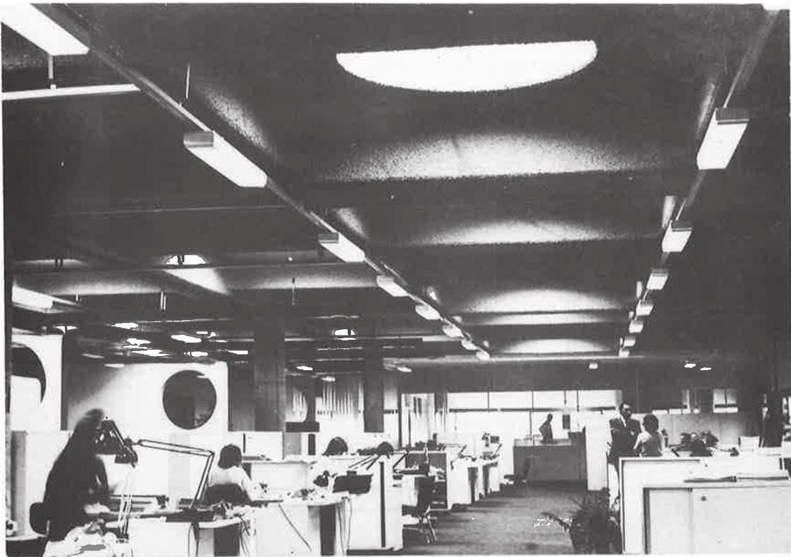
fig.3 esempio di piastre lasciate a vista - rif. IV
