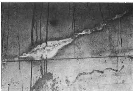
Fig. 5 - Efflorescenze saline
