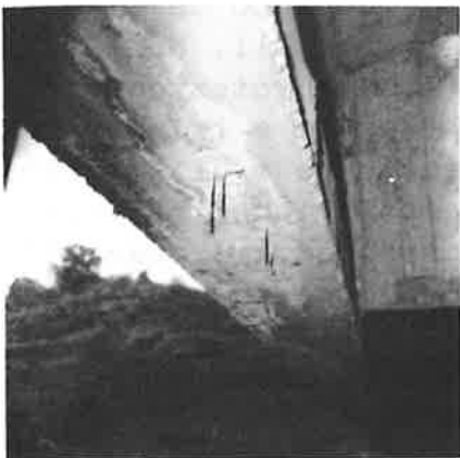
Fig. 3 - Iniezioni difettose
