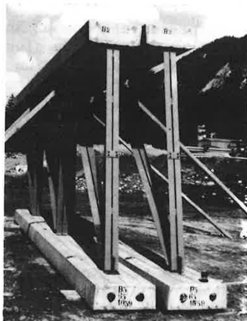
Fig. 20 - Presollecitazione della briglia inferiore di una delle due travi portanti reticolari.
