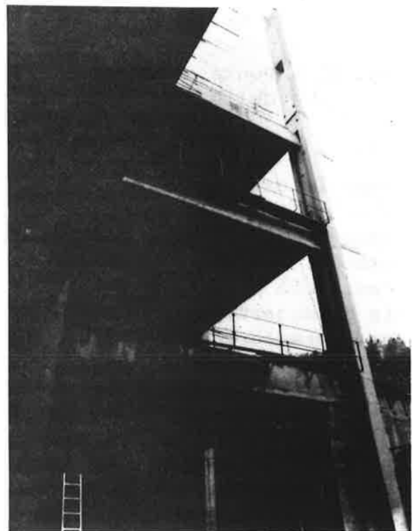
Fig. 24 - Uno dei pilastri lunghi complessivamente 3125 metri visto dal basso in fase di montaggio.
