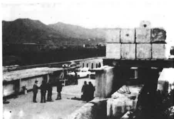
Fig. 11 - Prove delle travi
