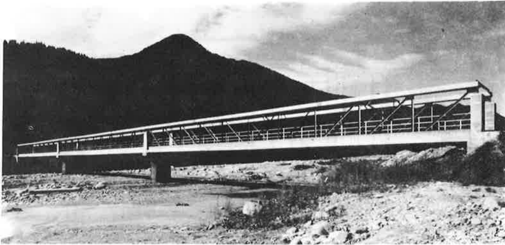
Fig. 18 - Ponte Meis a tre luci di 37,5 - 45 - 37,5 metri sul fiume Melezso nell'alta Valdossola, prefabbricato a conci e pre-sollecitato mediante cavi scorrevoli.
