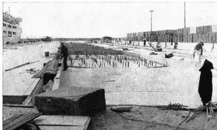
8 - Lo stoccaggio delle piastre d'impalcato; 9 - I pali  $\varnothing$  1300 mm ed i pulvini ottagonali per l'appoggio delle piastre prefabbricate; 10 - La posa in opera di una piastra; 11 - L'esecuzione della pavimentazione in cemento armato, spessa 40 cm, solidale con la piastra sottostante; 12 - Il molo in fase di completamento; 13 - Vista dell'intradosso delle piastre in opera.
