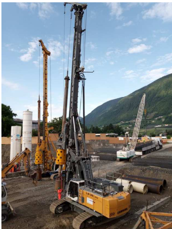
Figura 10. Foto 1 – Realizzazione dei pali di grande diametro
