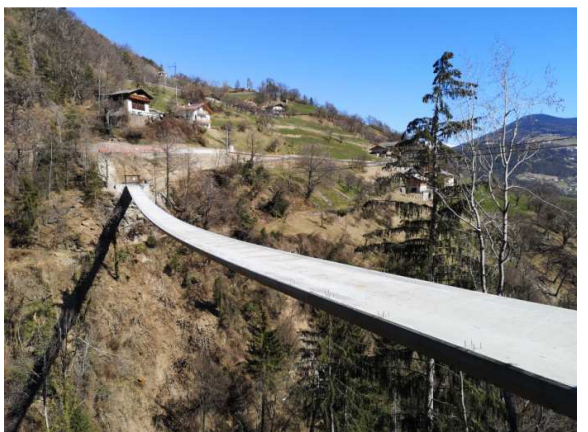
11. Varo dell'impalcato: fasi conclusive
