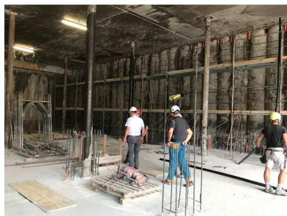
Figura 27 - Platea a livello -7 gettata in seconda fase (fase 15 dello schema costruttivo). La seconda parte della platea di fondo è già stata gettata; la posa delle armature delle rifodere laterali a completamento dei "contrafforti" è in corso. Sulla platea sono presenti delle nicchie (coperte da pannelli in legno) attraverso le quali verranno realizzati ulteriori tiranti di consolidamento.
