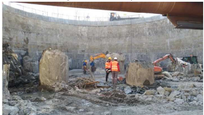
Figura 14. Scavo della fondazione della torre
