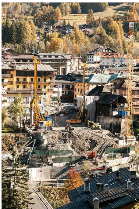
Figura 14 - Vista del cantiere durante le perforazioni dei pali secanti (archivio Fontana s.r.l.)
