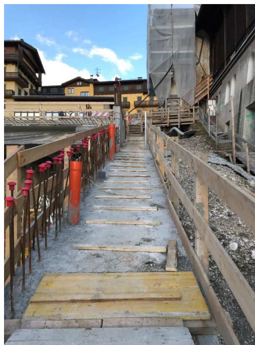
Figura 14 - Vista del cantiere durante le perforazioni dei pali secanti (archivio Fontana s.r.l.)
