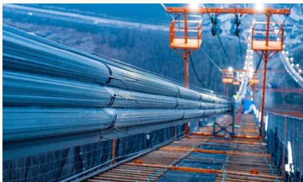
Figura 16. Un cavo principale durante la realizzazione
