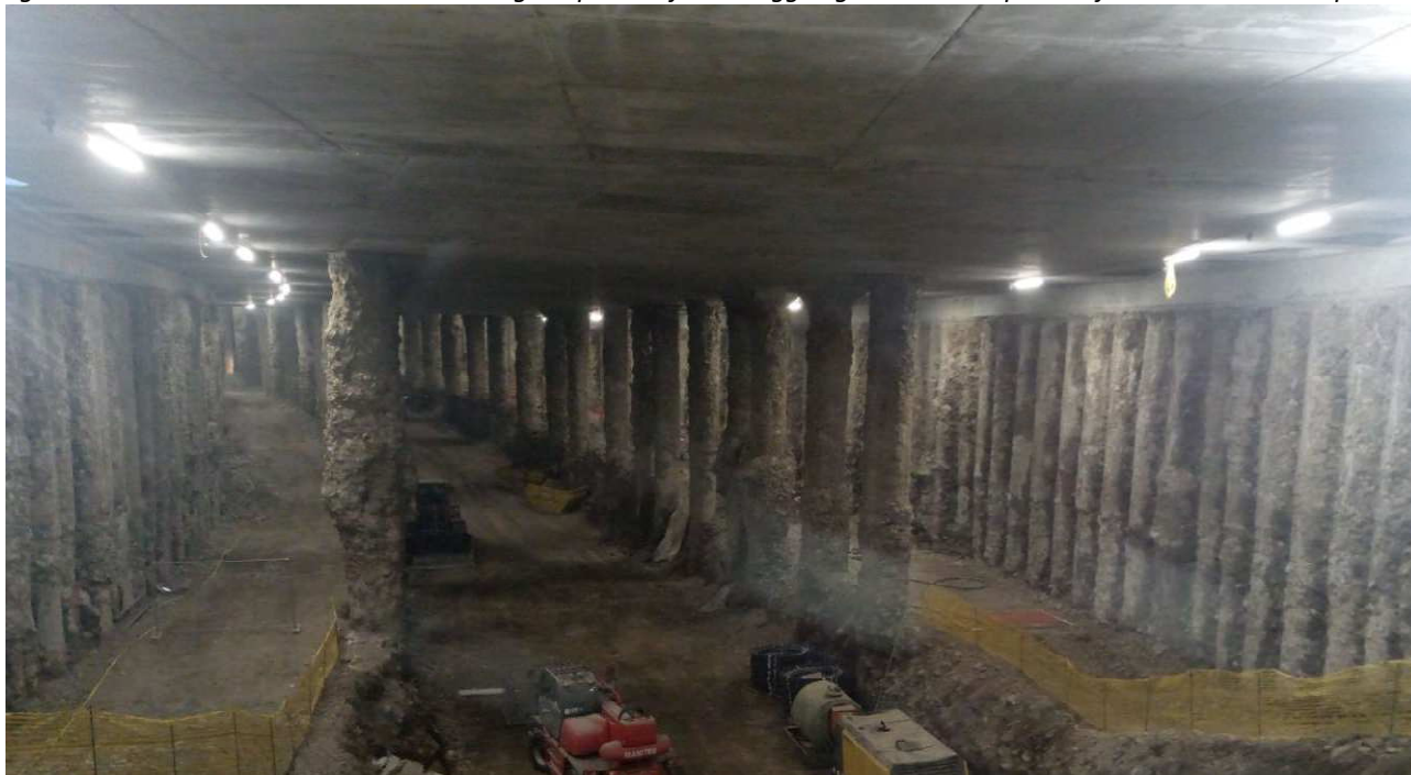
Figura 12. Foto 3 – Scavo mediante metodologia top-down fino al raggiungimento della quota di fondazione delle rampe
