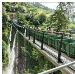
PONTE PEDONALE A "NASTRO TESO" SUL RIO GANDER A BARBIANO (BZ)
