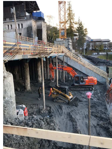
Figura 19 - Solaio di top down di prima fase a livello -3 (fase 4 dello schema di scavo). Sullo sfondo è visibile il terreno del versante che è stato opportunamente arretrato. Sono inoltre visibili i tubi verticali di sostegno provvisorio dei top down. Nella parte sinistra dell'immagine è visibile la rifodera con funzione di contrafforte.
