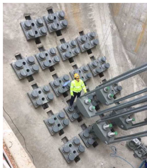
Figura 19. Sistema di ancoraggio
