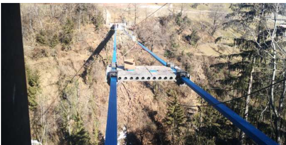
10. Posizionamento concio prefabbricato
