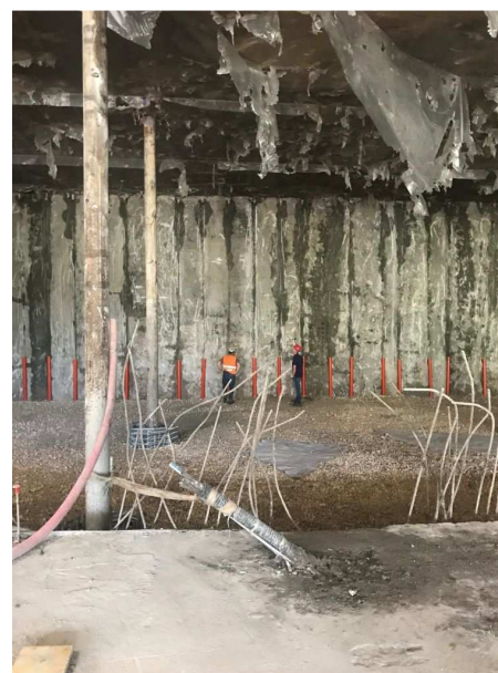
Figura 22 - Armatura della prima porzione di platea (fase 8 dello schema di scavo). Sullo sfondo sono visibili le riprese per la successiva realizzazione delle rifodere con funzione di contrafforte. Sui pali secanti sono già montati gli inghisaggi di collegamento. Sono visibili le riprese verticali del pilastro che ingloberà il tubo metallico avente funzione di pilastro provvisorio.
