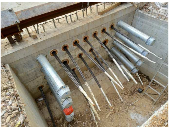
9. Inserimento cavi di post-tensione
