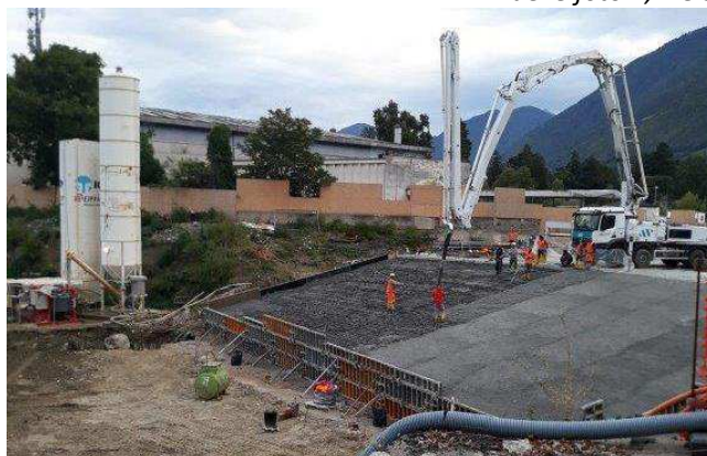
Figura 11. Foto 2 – Getto della soletta di copertura
