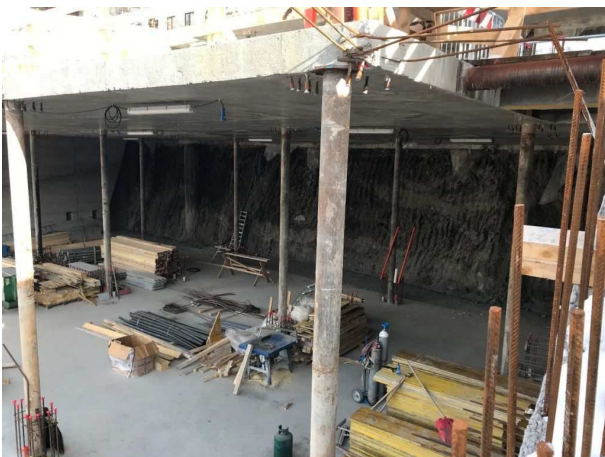
Figura 21 - Riprofilatura del versante sino alla quota della platea, al livello -7 (fase 7 dello schema di scavo). La rifodera con funzione di contrafforte al piano superiore è già realizzata. Al piano inferiore sono già stati realizzati gli inghisaggi di collegamento tra i pali secanti e la rifodera (non ancora gettata).
