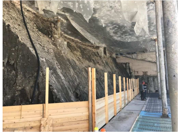
Figura 17 - Operazioni di scavo per arretramento del versante al di sotto del solaio di top-down a livello -1 (fase 3 dello schema di scavo). Si vedono i pali centrali che contengono all'interno il tubo provvisorio in acciaio necessario al sostegno del peso del solaio di top-down.
