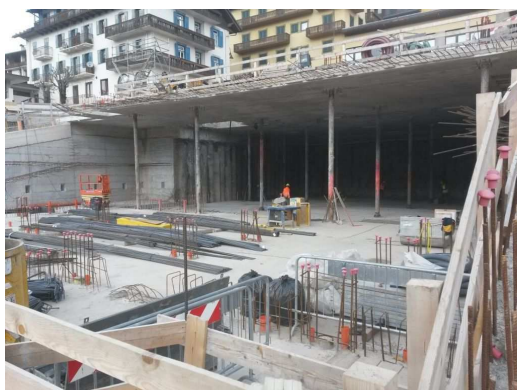
Figura 22 - Armatura della prima porzione di platea (fase 8 dello schema di scavo). Sullo sfondo sono visibili le riprese per la successiva realizzazione delle rifodere con funzione di contrafforte. Sui pali secanti sono già montati gli inghisaggi di collegamento. Sono visibili le riprese verticali del pilastro che ingloberà il tubo metallico avente funzione di pilastro provvisorio.
