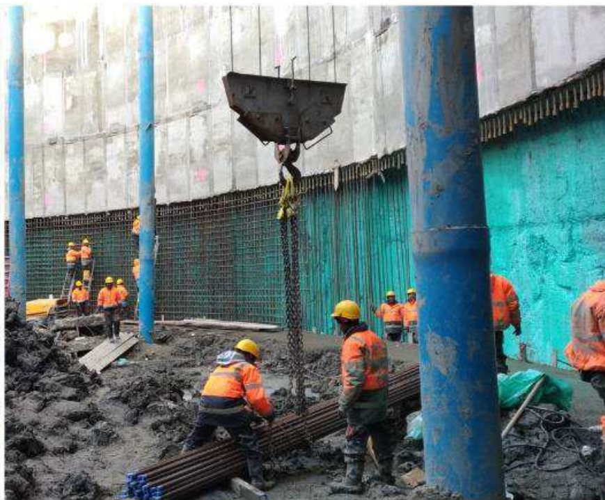
Figura 11. Scavo privo di puntoni temporanei o anelli di irrigidimento metallici
