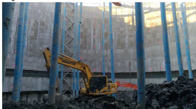
Figura 11. Scavo privo di puntoni temporanei o anelli di irrigidimento metallici
