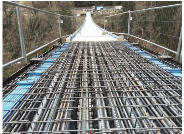
8. Parte terminale gettata in opera
