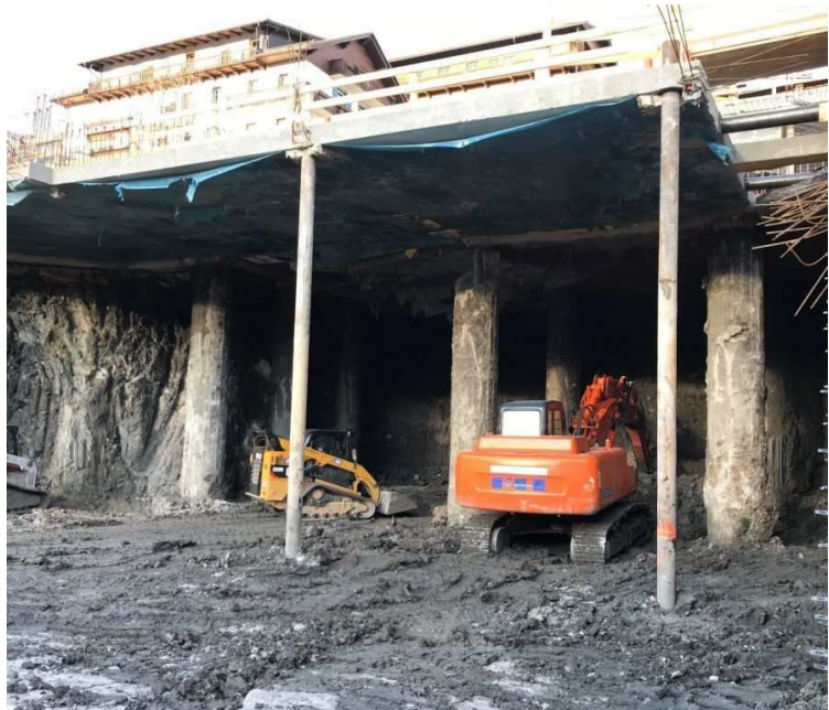
Figura 8 - Fase di scavo. Si può notare l'elevata componente argillosa del terreno di scavo.
