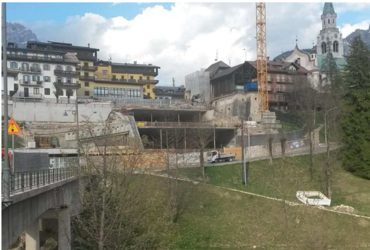
Figura 28 - Immagine del cantiere dalla prospettiva di valle durante gli scavi.
