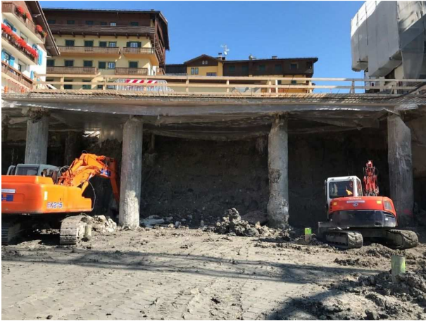
Figura 17 - Operazioni di scavo per arretramento del versante al di sotto del solaio di top-down a livello -1 (fase 3 dello schema di scavo). Si vedono i pali centrali che contengono all'interno il tubo provvisorio in acciaio necessario al sostegno del peso del solaio di top-down.
