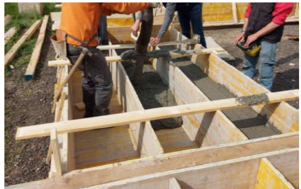
Figura 6: Prove di lavorabilità e di getto: armatura di frettaggio delle testate di post-tensione (a) e fase di getto (b)
