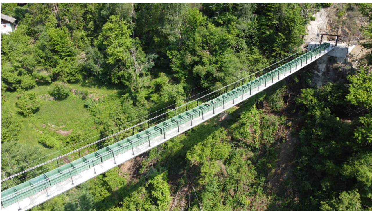
15. Applicazione del carico di collaudo con contenitori d'acqua
