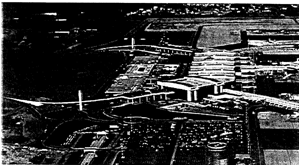
Fig. 1 Vista dell'aerostazione di Malpensa 2000 e dei viadotti strallati d'accesso
