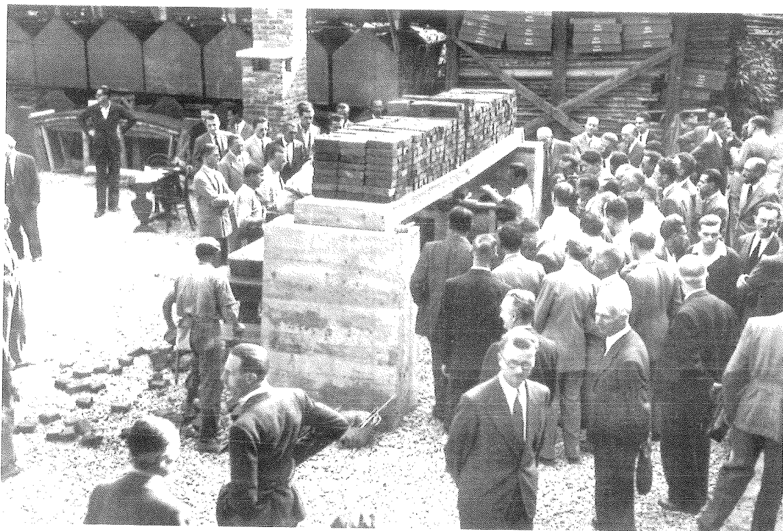
Fig. 4 Prova di carico su di un solaio laterocementizio con travetti precompressi
