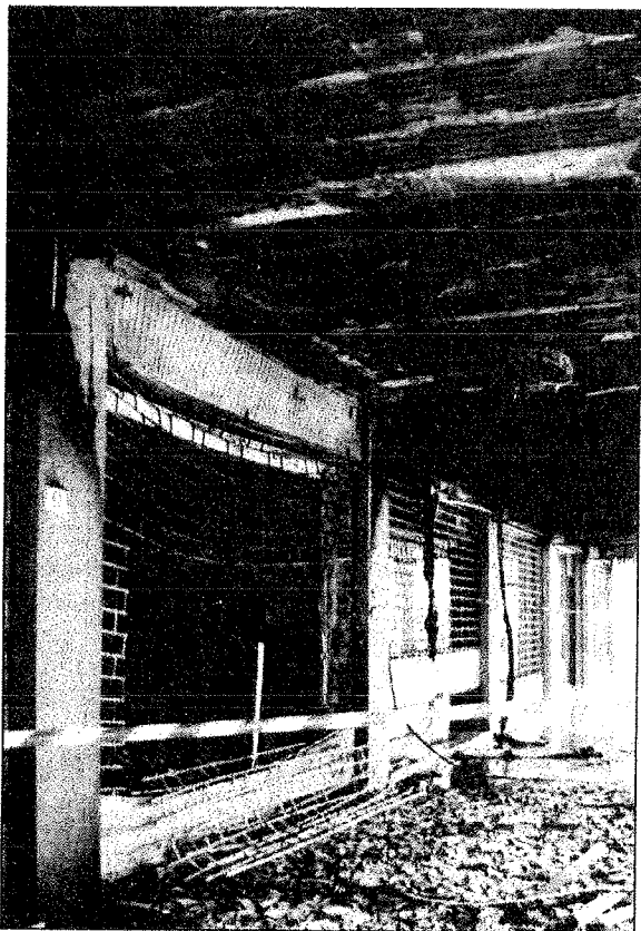
Fig. 8: Danni arrecati dall'incendio nella zona del porticato antistante il negozio.
