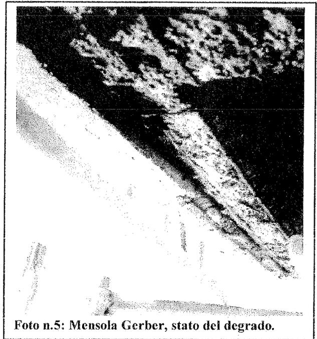
**Foto n.5: Mensola Gerber, stato del degrado.**
