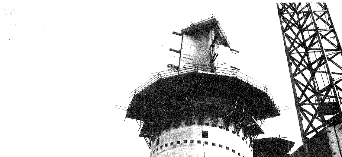
Fig. 2 - vista cassaforma per solaio a quota 33,30 m.
