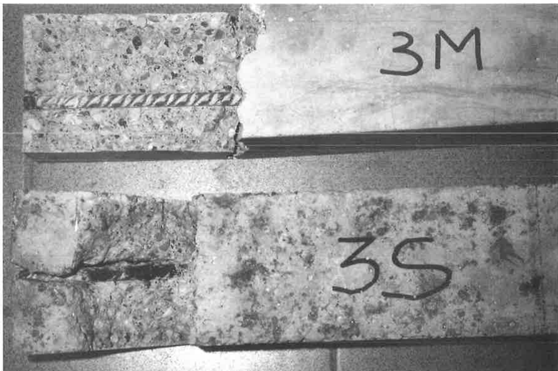
Fig. 7-Particolare dello stato di ossidazione delle barre
