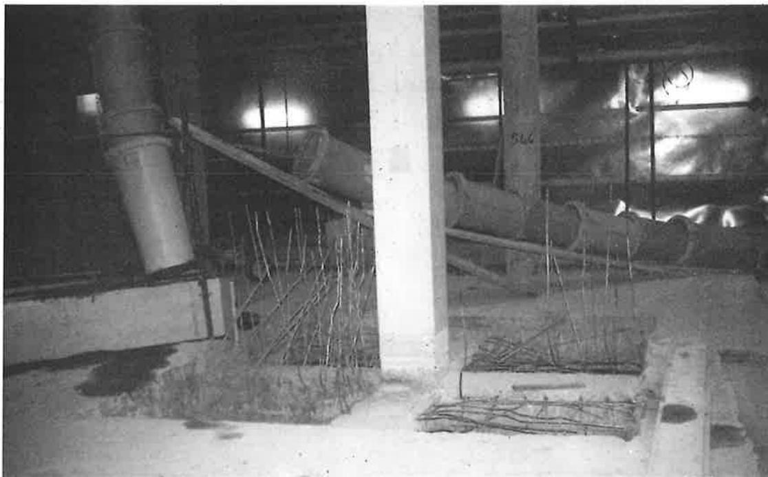
Fotografia n.1: vista della elevazione del pilastro da demolire; sono visibili i varchi realizzati nella soletta (q -9,815) per consentire l'accesso alla fondazione.
